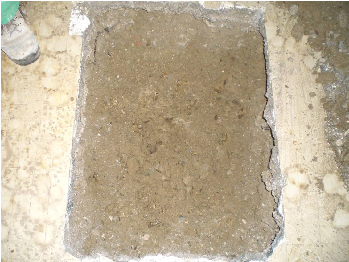
Edificio F2 – Pozzetto per campione F2/3
