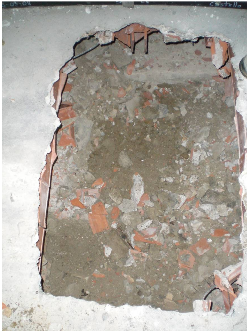
Edificio F1 – Pozzetto per campione F1/2
