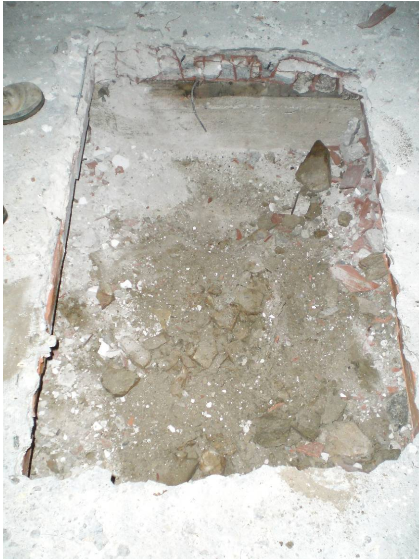
Edificio F1 – Pozzetto per campione F1/1
