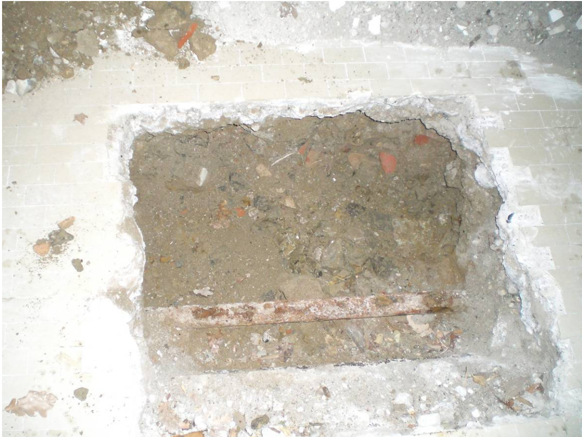
Edificio F2 – Pozzetto per campione F2/2
