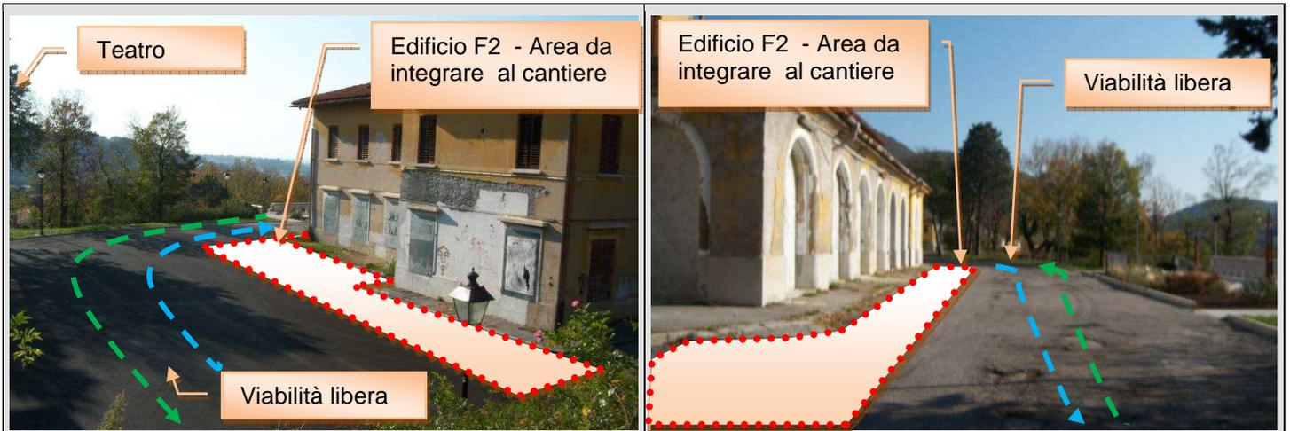
Al fine di contenere ulteriormente i disagi recati alla viabilità interna causati dalla presenza di mezzi di cantiere in sosta, si è previsto di creare uno spazio calmo all'interno dell'area di cantiere, in modo da permettere ai mezzi in ingresso e in attesa di scarico merci di poter temporaneamente sostare all'interno di una zona sicura.
