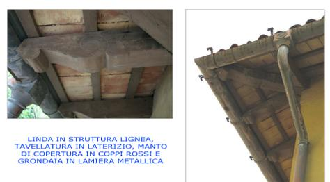
LINDA IN STRUTTURA LIGNEA, TAVELLATURA IN LATERIZIO, MANTO DI COPERTURA IN COPPI ROSSI E GRONDAIA IN LAMIERA METALLICA
