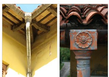
CASSETTA DI RACCORDO PER PLUVIALI IN LAMIERA METALLICA
