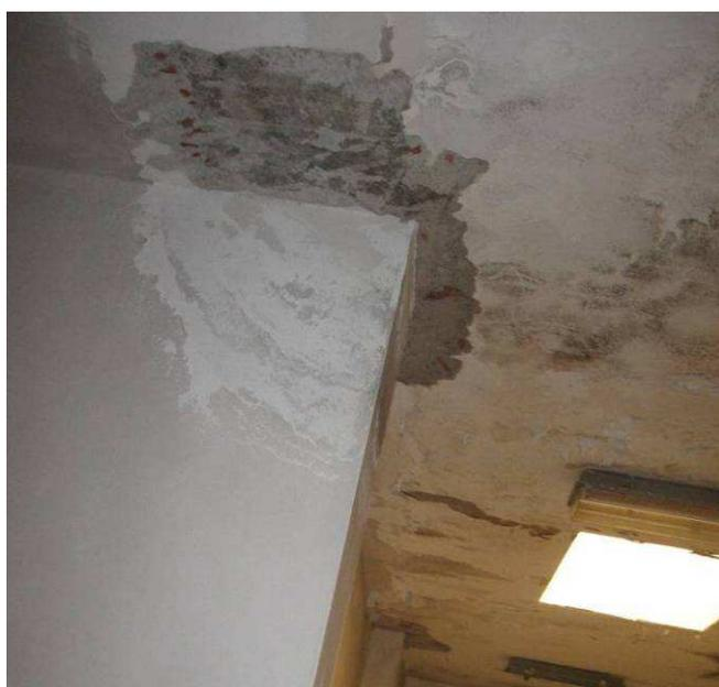
**Figura 4-9 Infiltrazioni d'acqua nella copertura dell'ampliamento**
