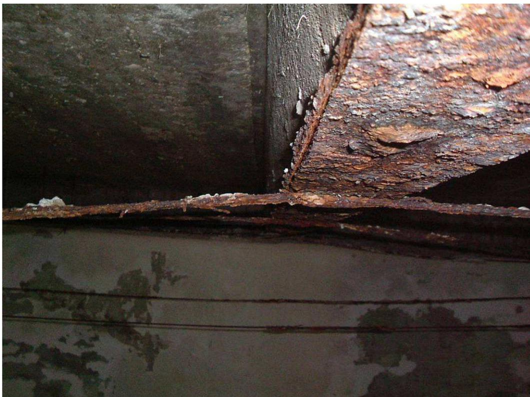
**Figura 4-4** ala inferiore di profilo laminato con ruggine sfogliante
