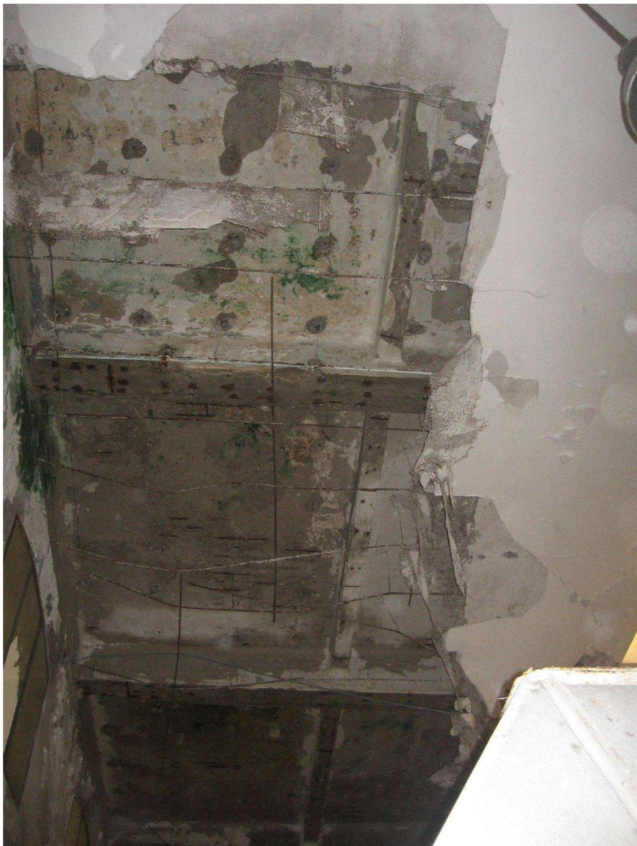
**Figura 4-7 Copertura cucina. Crollo del controsoffitto e splitting nei calcestruzzi delle travi e nelle solette**
