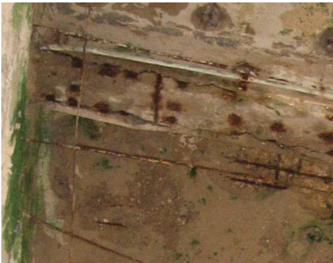
**Figura 4-8 Particolare dei danni provocati dall'acqua ai calcestruzzi ed alle armature. Visibile lo splitting dei calcestruzzi per l'ossidazione esfoliante delle barre armatura**
