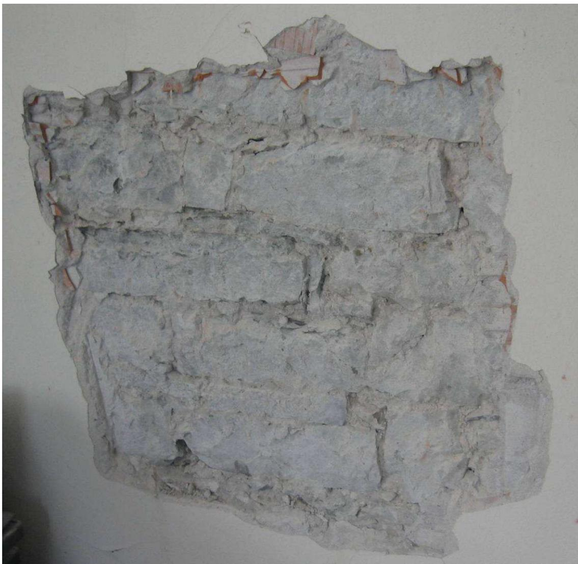
**Figura 4-12 Muratura in pietre a spacco con buona tessitura muro trasversale a piano terra.**
