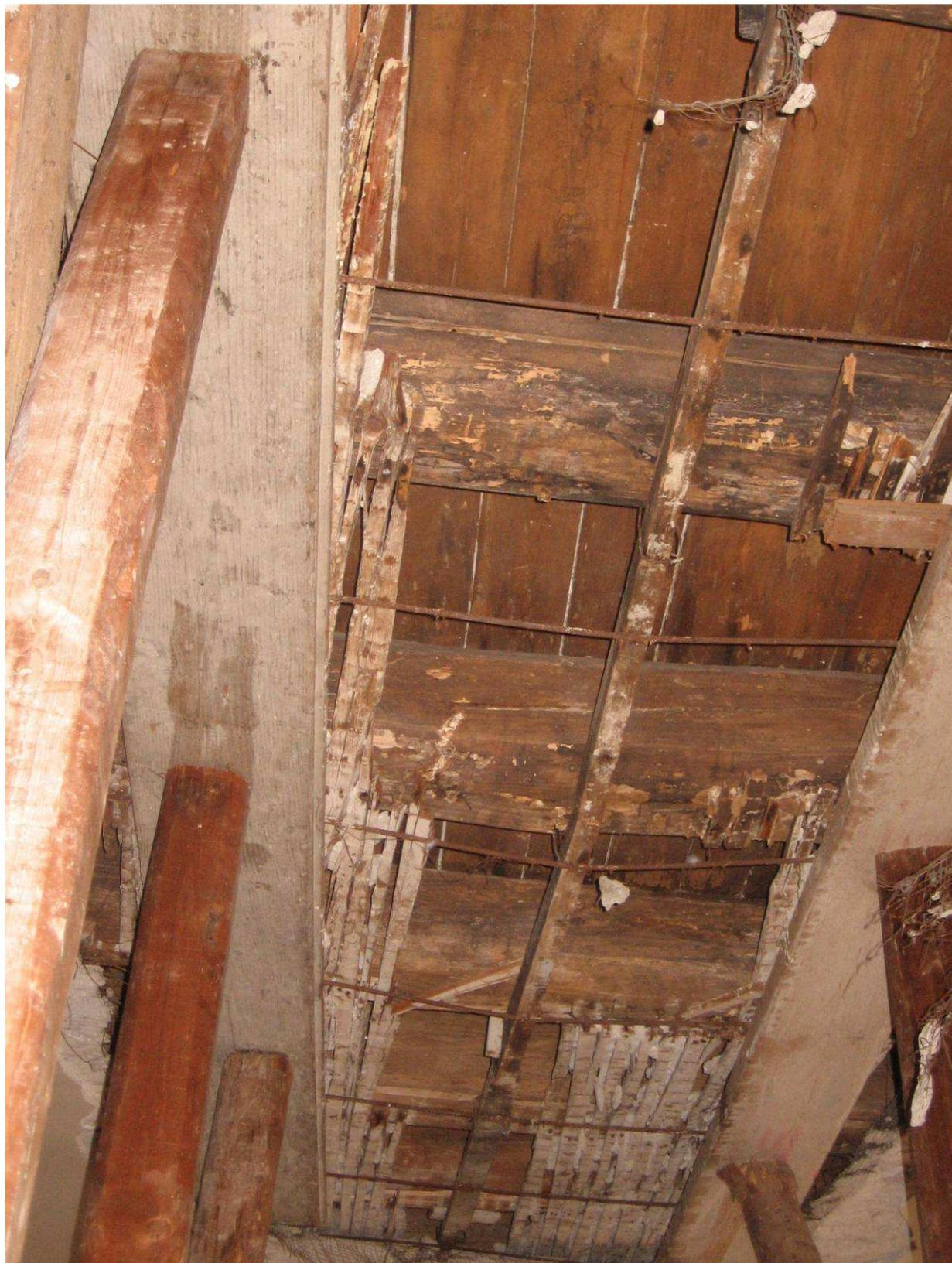
**Figura 4-10** Corpo ovest. Soffitto a piano primo staticamente fortemente compromesso a causa delle infiltrazioni d'acqua. Necessita una completa sostituzione
