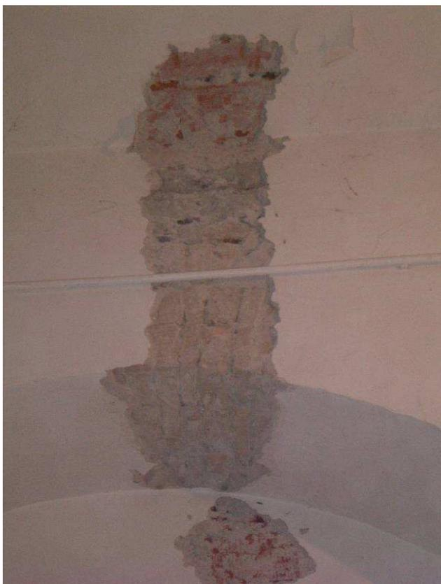
**Figura 4-15 Muratura a nudo in corrispondenza ad un arco interno nella zona ex portico a piano terra. Si noti la buona tessitura muraria della muratura di tre teste di altezza alla quale è sovrapposta la muratura in pietra comune a tutta l'opera.**
