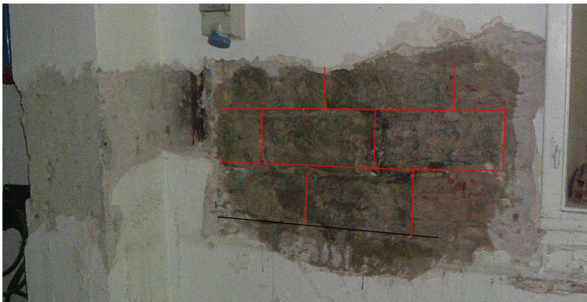
**Figura 4-14 Muratura nuda corrispondente al piano terra della zona di ampliamento. In passato muro esterno di prospetto. Si noti la buona tessitura muraria delle pietre e, in corrispondenza dell'apertura sulla sinistra (passavivande) la squadratura in mattoni della stessa ben ammorsata. Sulla sinistra si vede invece un pilastro in calcestruzzo semplicemente accostato.**
