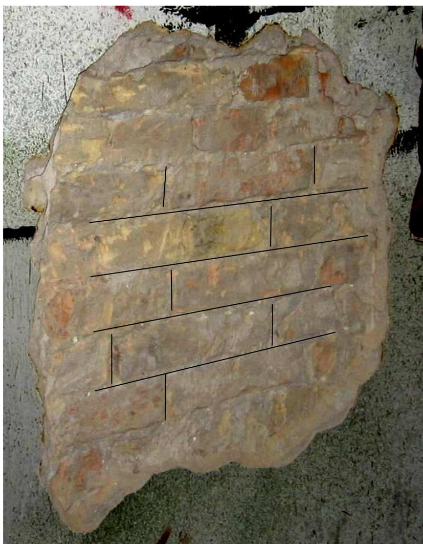
Figura 4-11 Muratura in laterizio saggio sul muro di spina a piano terra. Tessitura muraria
