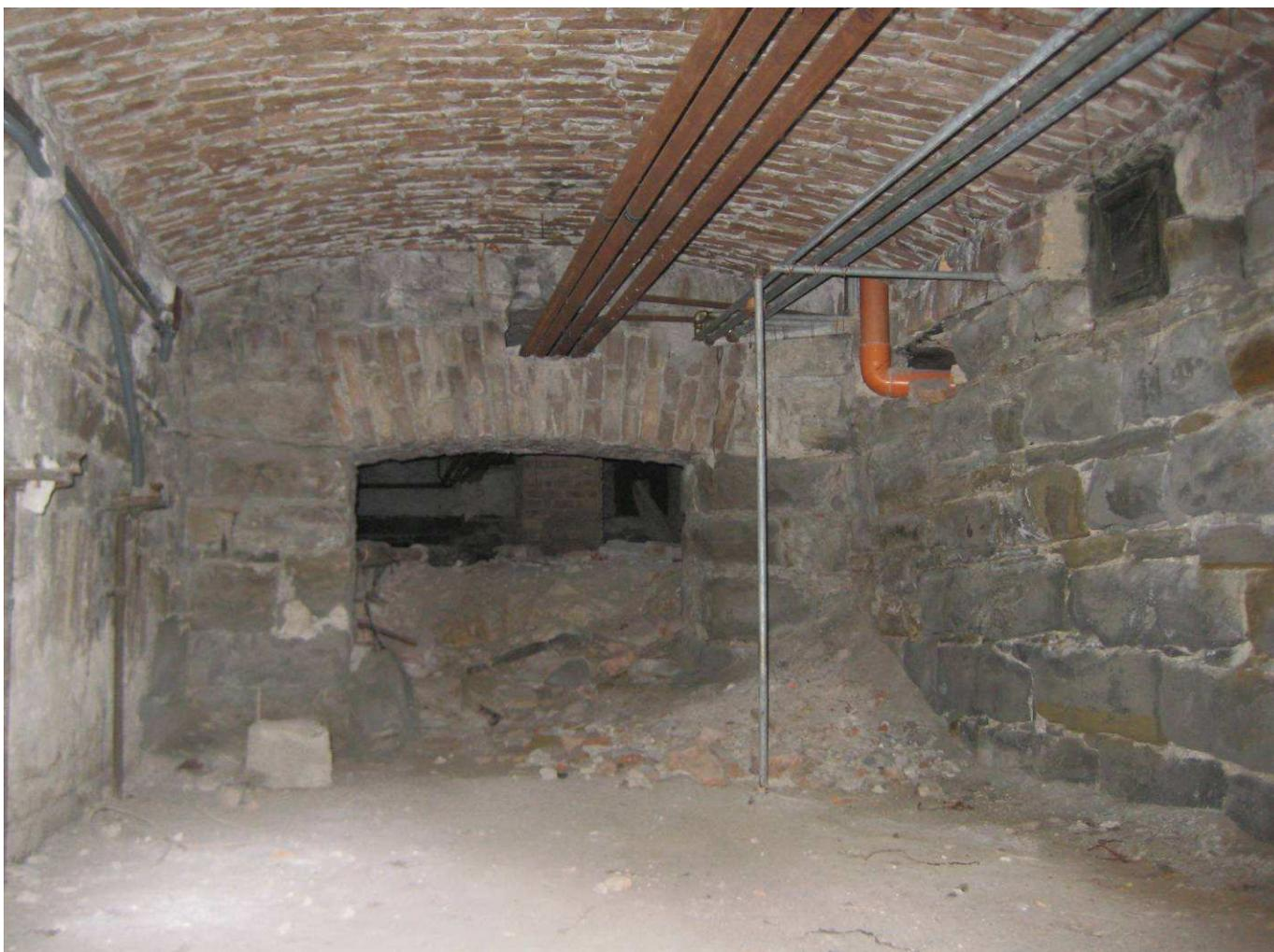
**Figura 4-13 Muratura nuda del cantinato così come da realizzazione originale. Si nota la buona tessitura muraria delle pietre dei muri e l'architrave voltato dell'apertura in mattoni pieni di 3 teste di altezza.**
