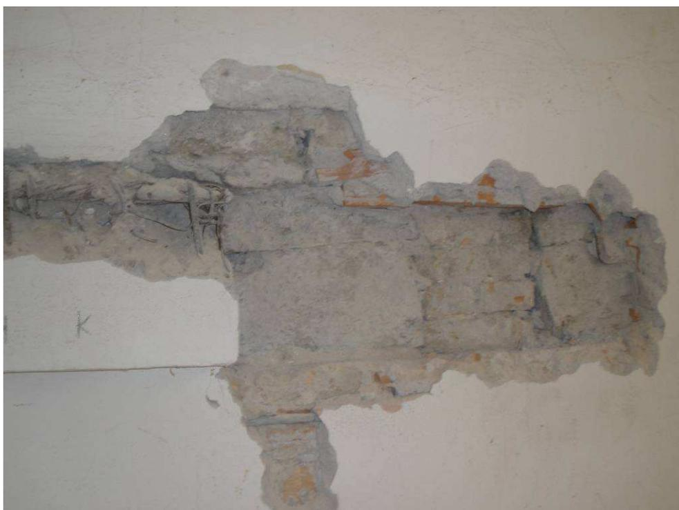
**Figura 2-74** Sondaggio sulla parete esterna del locale "Soggiorno" per individuare l'originario collegamento del solaio di piano primo, realizzato secondo il brevetto Matrai, e successivamente demolito.
