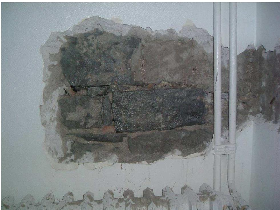
**Figura 6-11** Sondaggio a parete da cui si evidenzia la presenza di una parete in pietra squadrata e una parete di c.a , realizzata negli anni '60, per realizzare un portavivande.
