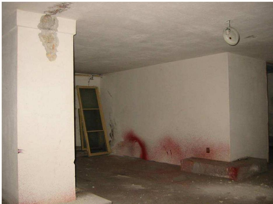
**Figura 2-14** Foto dei locali dell'interrato in cui si vedono sporgere dal pavimento finito l'estradosso delle travi di fondazione.
