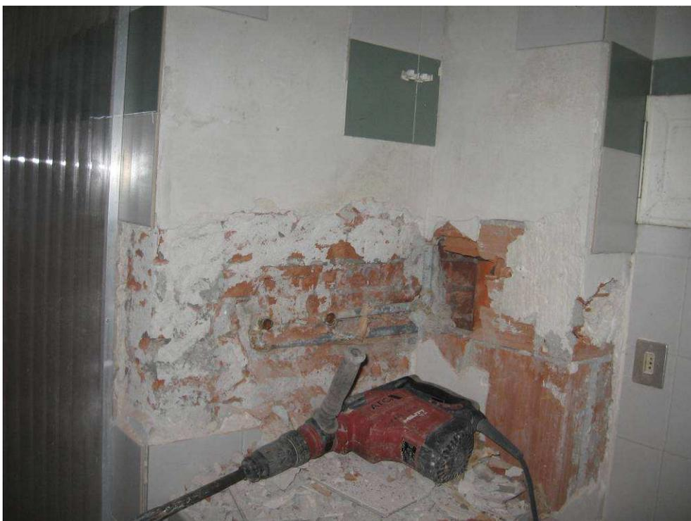
**Figura 2-26** Sondaggio a parete in cui si evidenzia la presenza di murature piene e forate per la realizzazione di una canale di raccolta degli indumenti sporchi in collegamento diretto con il piano seminterrato.
