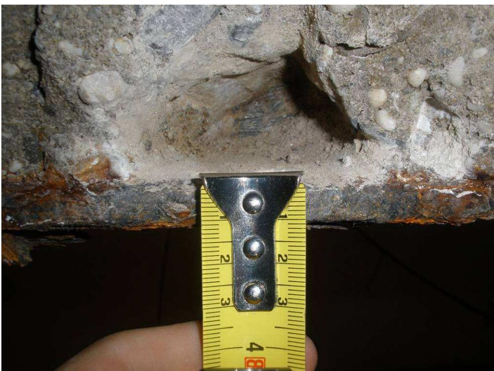
**Figura 2-76** Sondaggio sul solaio di piano copertura realizzato nel locale "Dormitorio", in cui si è messa in evidenza una putrella e l'armatura della soletta.
