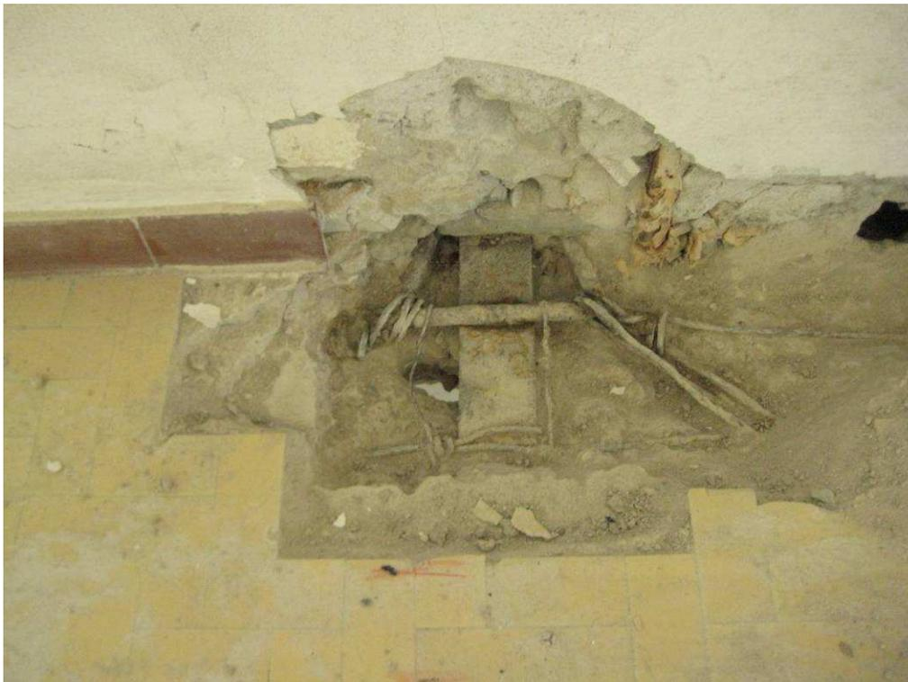
Figura 2-117 Saggio in corrispondenza dell'attacco a muro della putrella che sostiene il solaio Matrai tipo 4.
