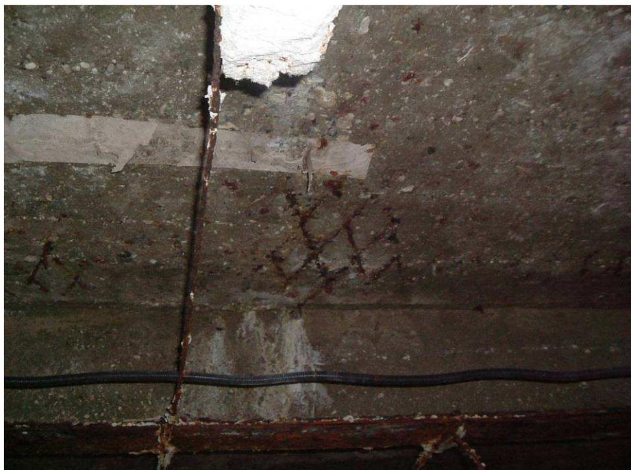
**Figura 2-75 Sondaggio sul solaio di piano copertura realizzato nel locale "Dormitorio", in cui si è messa in evidenza una putrella e l'armatura della soletta.**
