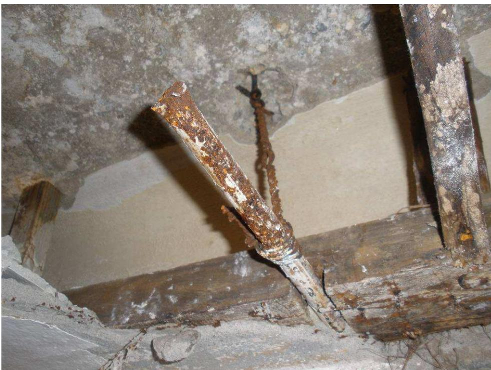
**Figura 2-92 Sondaggio a soffitto realizzato sul solaio di copertura del corridoio in cui si mette in luce la presenza di un travetto ligneo a cui è stato collegato il controsoffitto.**
