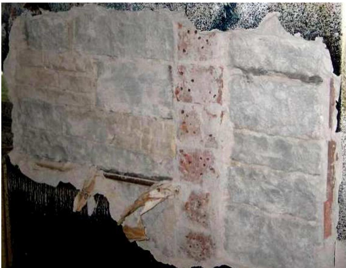
**Figura 2-29** Sondaggio a parete che mette in luce la parete in pietra squadrata ed uno strato di intonaco. Nella parte centrale sono visibili i laterizi a chiusura del cavedio impiantistico.
