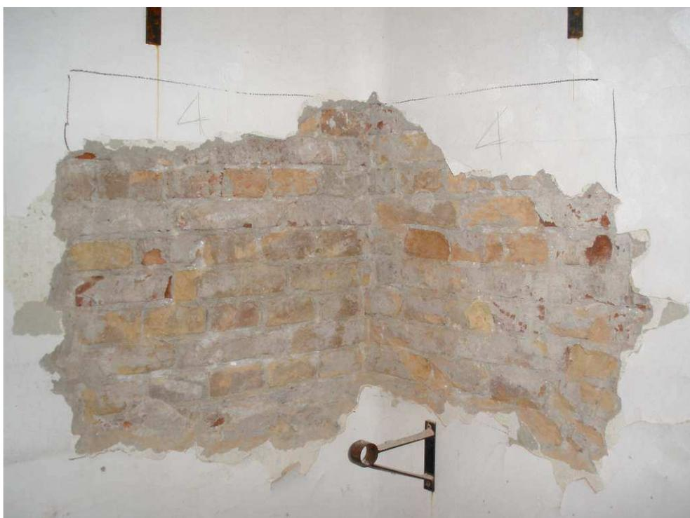
**Figura 2-40 Sondaggio a parete da cui si evinca la presenza di strato di intonaco e di 1 cm e due pareti di mattoni pieni, ammassate.**
