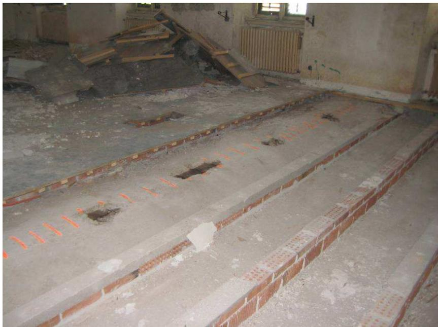
Figura 2-111 Sondaggio nel solaio del piano primo in cui è stato rimosso il pavimento in legno e si può vedere i muretti che lo sostengono. Sono stati eseguito dei fori per individuare le caratteristiche del solaio Matrai tipo 3.
