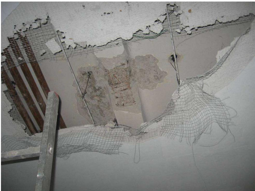
Figura 2-12 Sondaggio sul solaio Matrai
