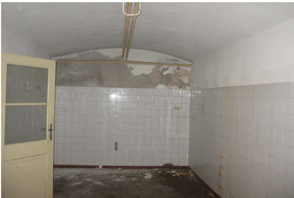
**Figura 2-21 RILIEVO R.A.11.B-** Questo locale situato al piano interrato presenta una copertura realizzata con una volta in muratura.
