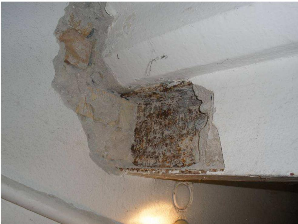
**Figura 2-95 Particolare di collegamenti tra putrella del pianerottolo e muratura portante.**
