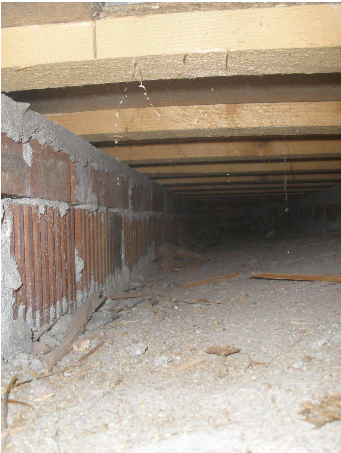
**Figura 2-46 SONDAGGIO 7C – Sondaggio a pavimento sul solaio di piano primo, in cui è stato portata alla luce la struttura portante.**
