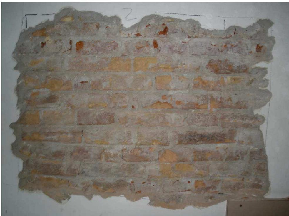
Figura 2-38 Sondaggio a parete in cui si evidenzia 2 cm di intonaco e una parete di mattoni pieni.
