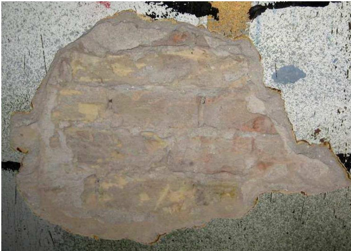
**Figura 2-28 Sondaggio a parete che mette in luce la presenza di una parete in mattoni pieni e di un rivestimento di intonaco.**
