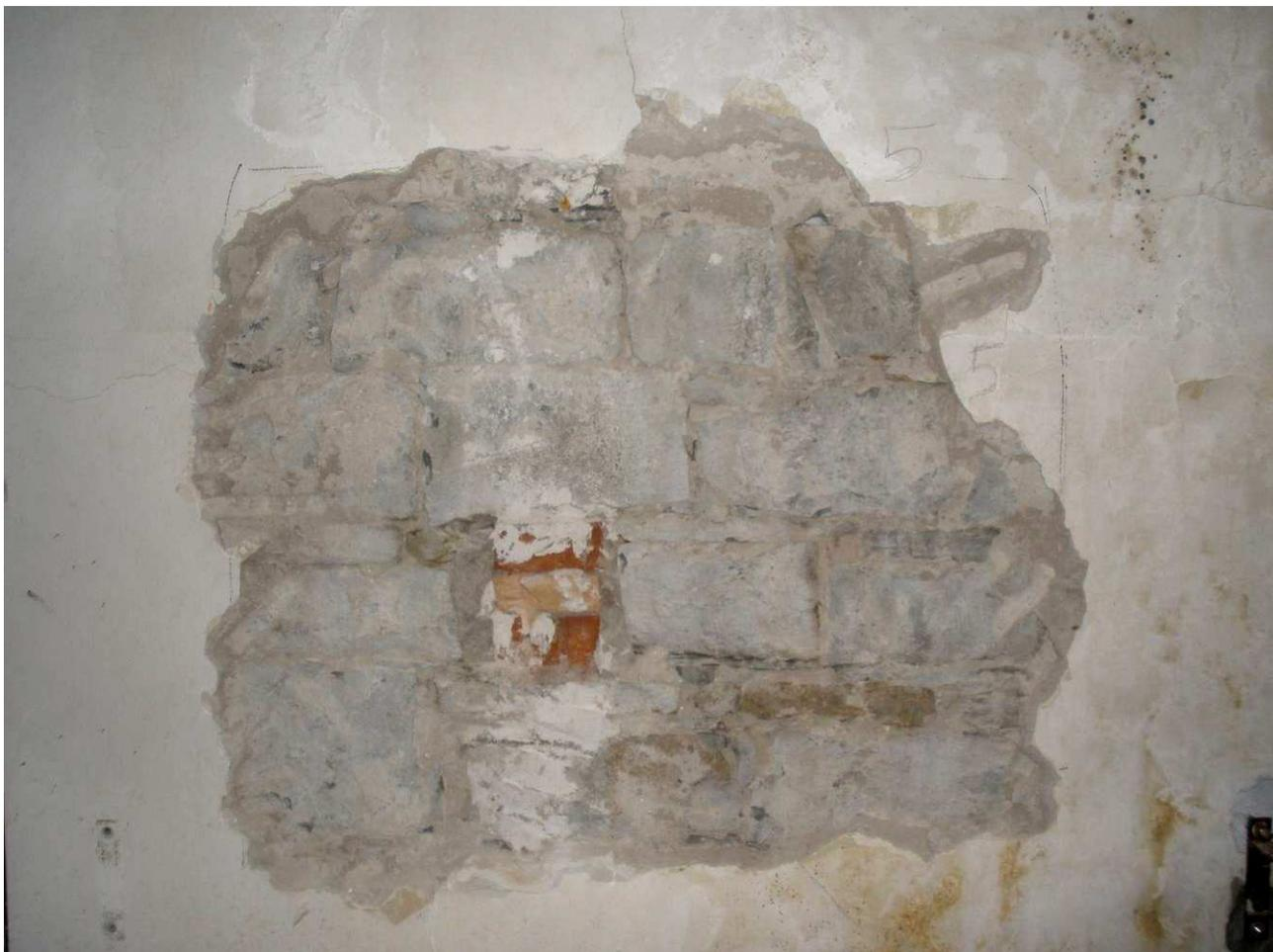
**Figura 2-42 Sondaggio a parete da cui si evidenzia uno strato di intonaco di 3-4 cm e una parete in pietra quadrata.**
