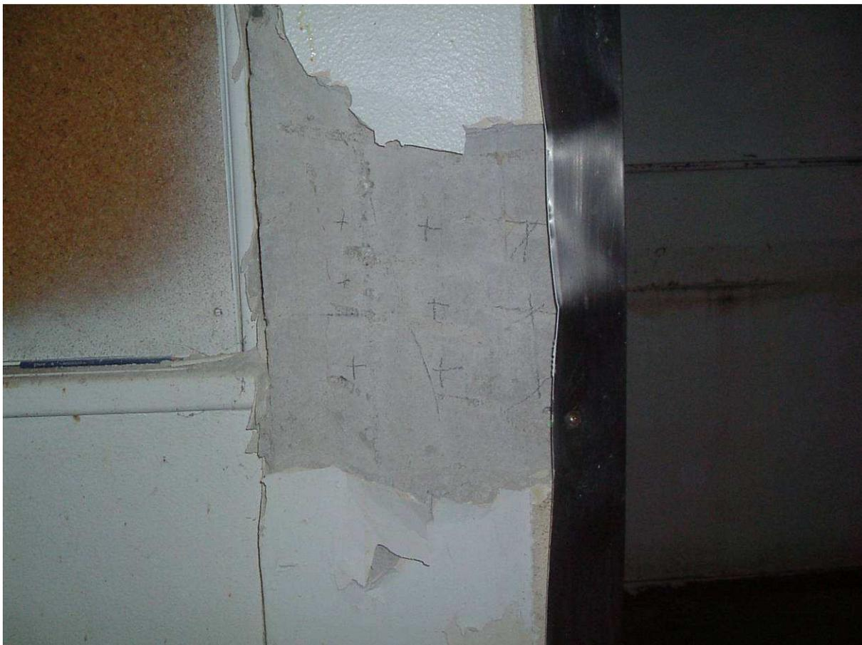
Figura 6-1 Sondaggio a parete in cui si evidenzia la realizzazione di un pilastro in c.a.
