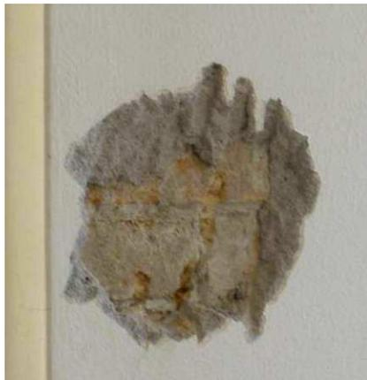
**Figura 2-68 Sondaggio a parete in cui si evidenzia la presenza di una parete in mattoni pieni con uno strato di intonaco.**
