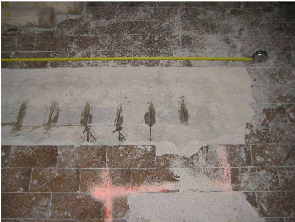
**Figura 2-120 Rilievo dell'estradosso del solaio Matrai tipo 1 del piano terra in corrispondenza della putrella. Si è misurato il passo dei fili in mezzeria.**
