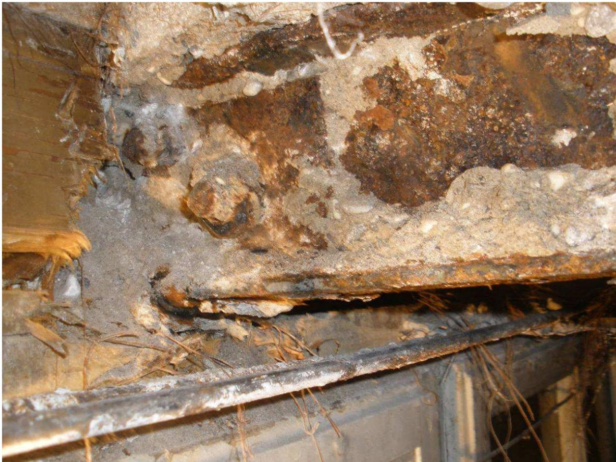
**Figura 2-85 Sondaggio realizzato sul solaio di copertura del corridoio in cui si mette in luce il collegamento bullonato delle putrelle.**
