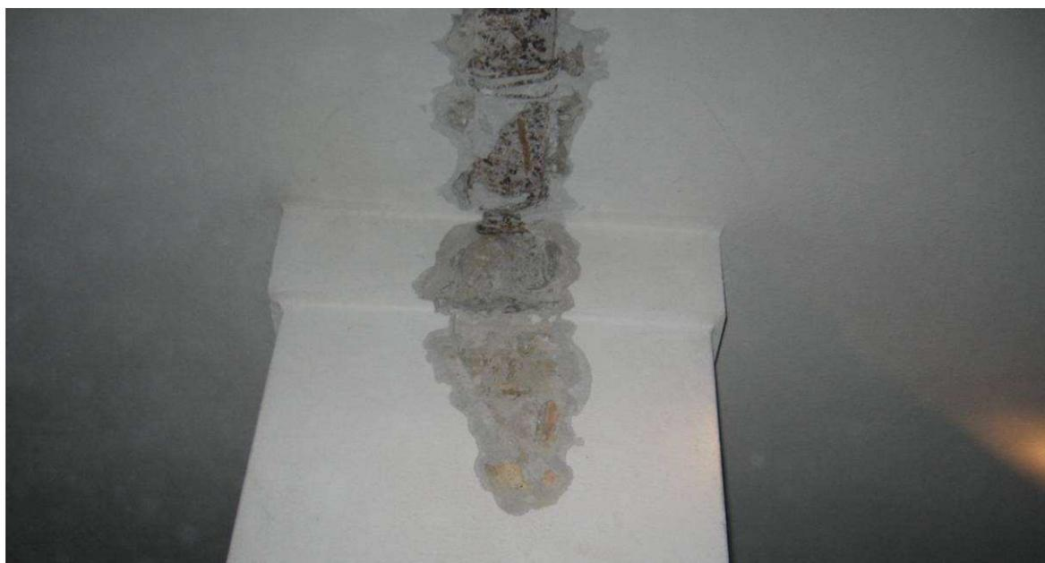
**Figura 2-16 Il sondaggio rivela la presenza di una putrella metallica in acciaio, posta su un appoggio di pietra che corona un pilastro realizzato in mattoni pieni.**
