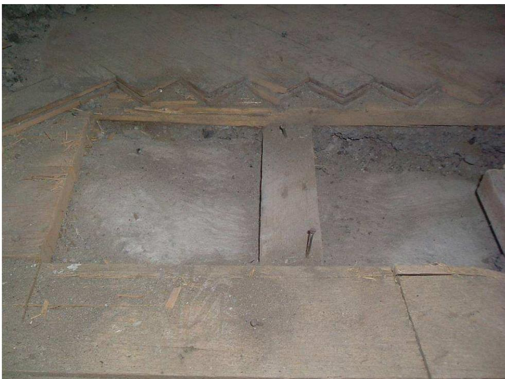
Figura 2-86 Demolizione della pavimentazione esistente e degli strati superiori di riempimento.
