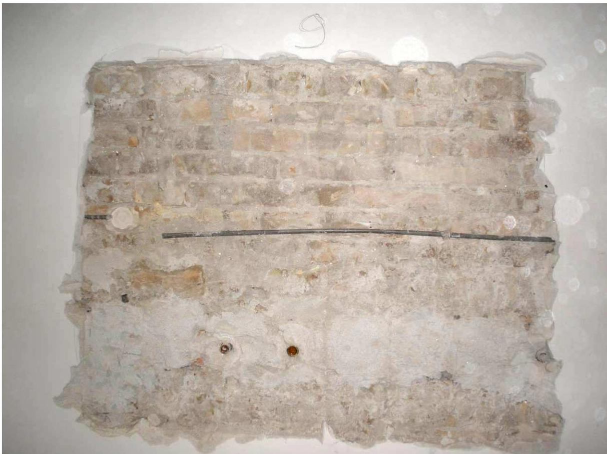
**Figura 2-54 Sondaggio a parete in cui si evince una parete di mattoni pieni con uno strato di intonaco di 4 cm.**
