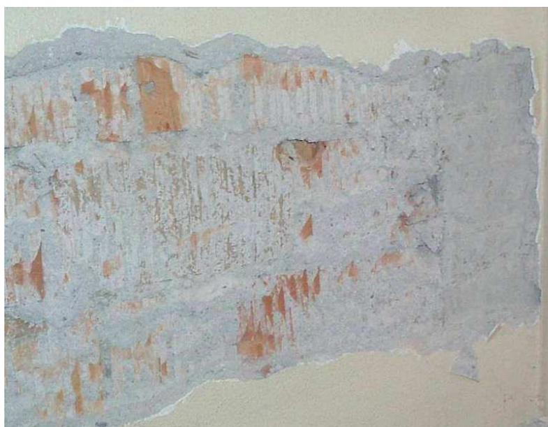
**Figura 6-4 Nella parte finale del sondaggio si è portato in luce anche il pilastro in c.a. rilevato durante il saggio precedente.**
