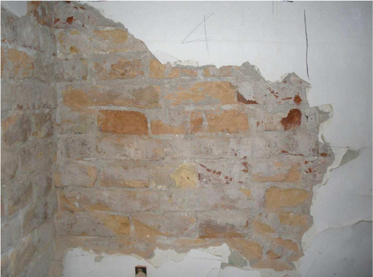
**Figura 2-41** Sondaggio a parete da cui si evince la presenza di strato di intonaco e di 1 cm e due pareti di mattoni pieni, ammorsate.
