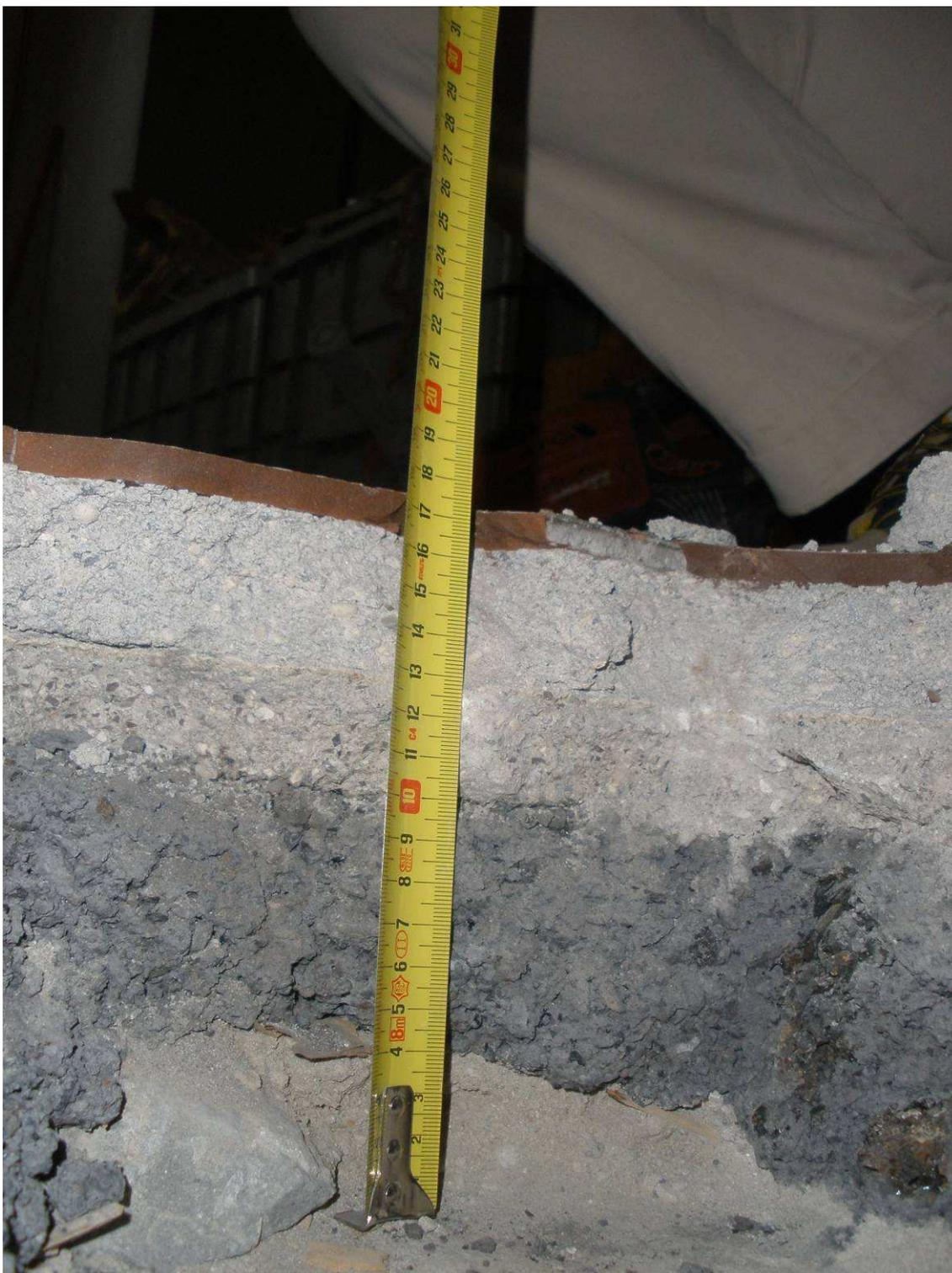
**Figura 2-109** Stratigrafia della pavimentazione, composta da 1 cm di gres, 3,5 cm di malata di allettamento, e 4,5 cm di calcestruzzo alleggerito. La struttura portante del solaio è di tipo Matrai, come evidenziato nella piante allegate.
