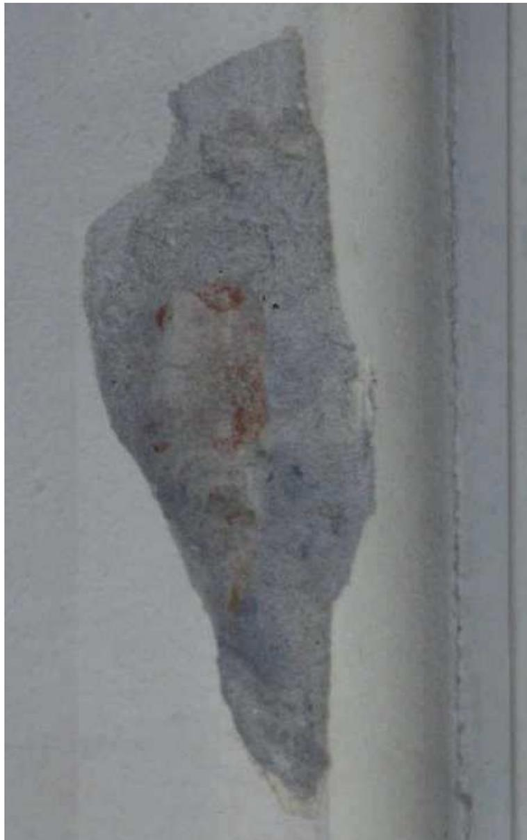
**Figura 2-67 Sondaggio a parete in cui si evidenzia la presenza di una parete in mattoni pieni con uno strato di intonaco.**
