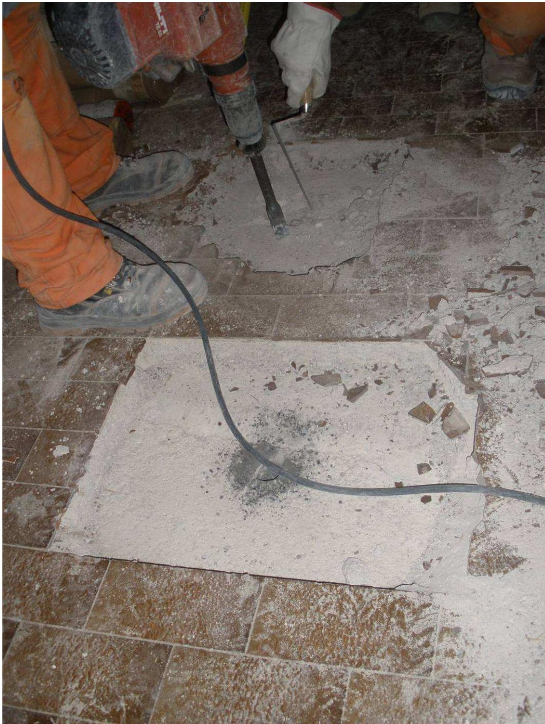
Figura 2-108 Sondaggio a pavimento sul solaio di piano terra in corrispondenza del locale "Refettorio".
