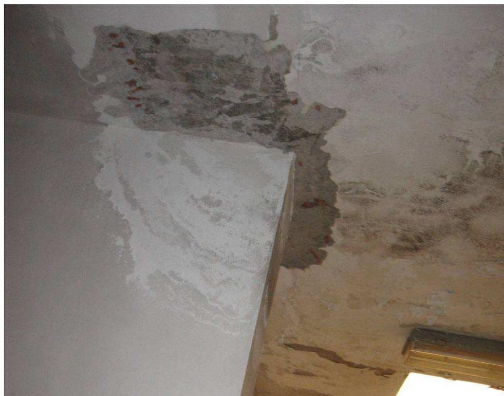
Figura 6-26 Sondaggio a soffitto realizzato sul solaio di sotto tetto da cui si evidenzia la presenza di una soletta di c.a.
