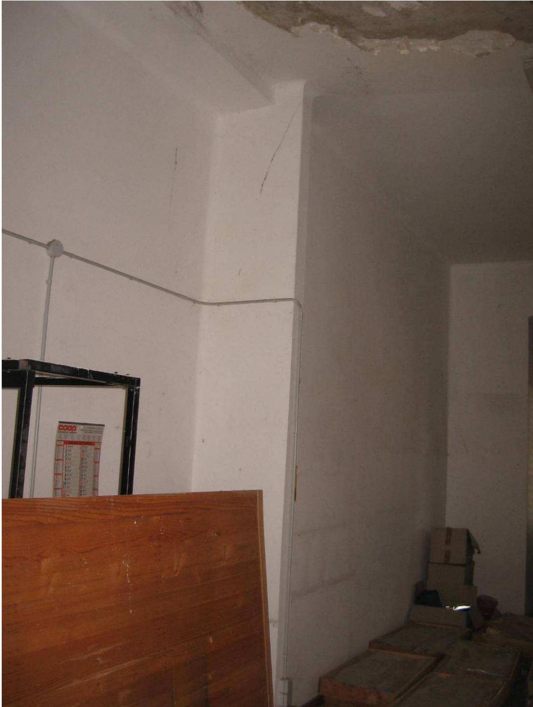
Figura 2-25 Pareti interne del locale "Cucinetta", in parte realizzato con mattoni pieni nel 1906 ed in parte realizzato durante gli ultimi interventi di adeguamento.
