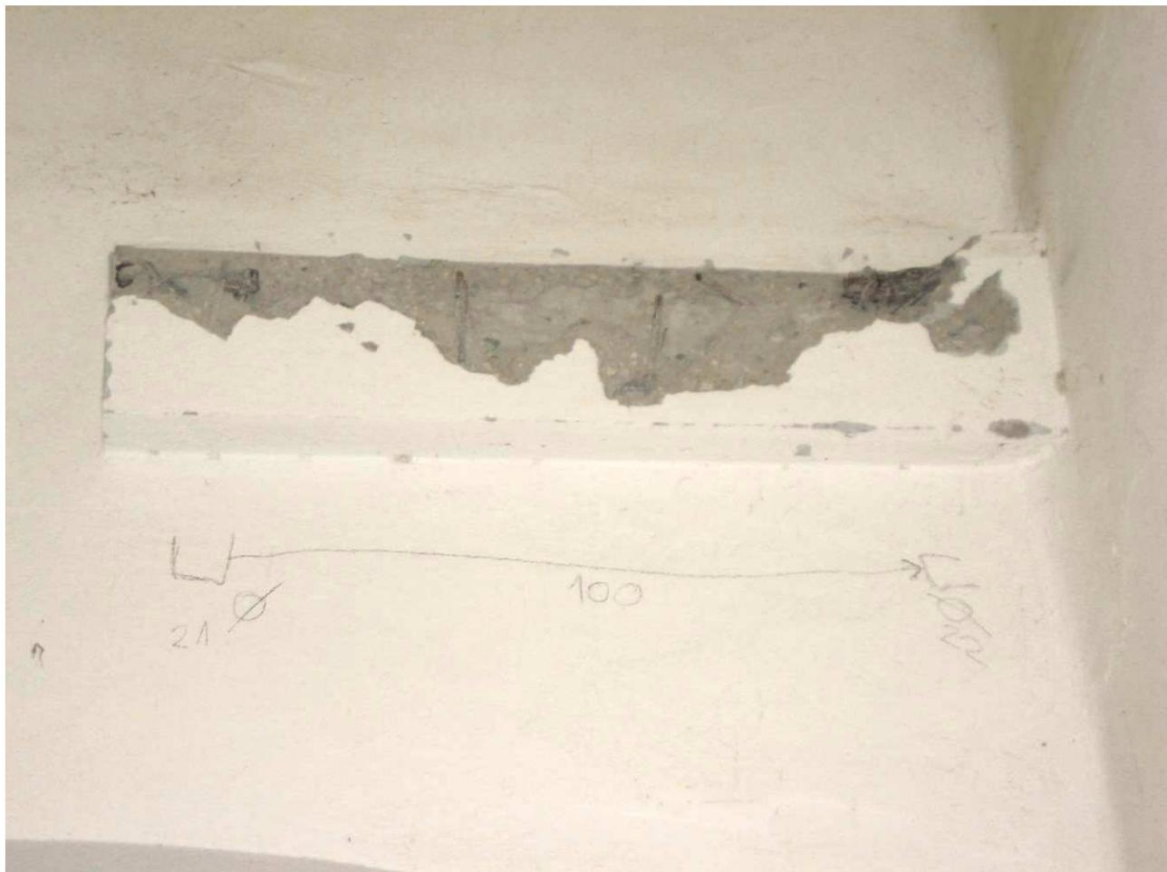
Figura 2-122 Rimozione del coprifermo nel doppio volume.
