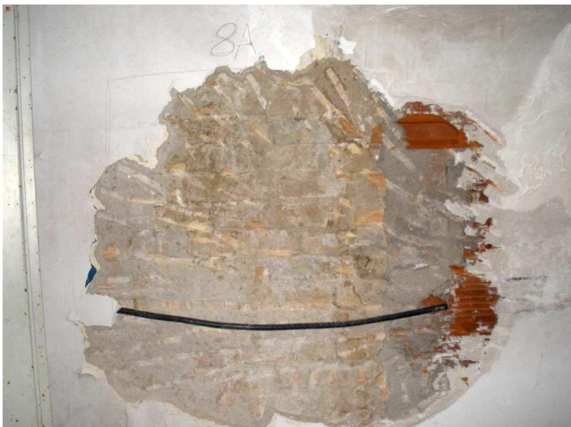
Figura 2-52 SONDAGGIO 8A a parete in cui si evidenzia una parete in mattoni pieni con ricoprimento di intonaco di 2,3 cm.
