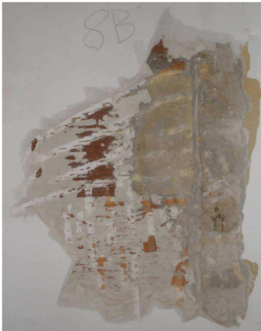
**Figura 2-53 SONDAGGIO 8B a parete in cui si evidenzia una parete di mattoni pieni e rivestimento di intonaco con laterizio.**
