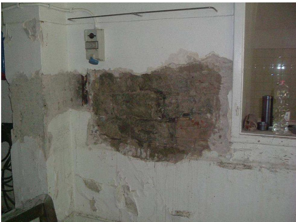
**Figura 6-9** Sondaggio a parete da cui si evidenzia la presenza di un pilastro in c.a. (allineato con i pilastri presenti nella sala) e una parete in pietra squadrata.
