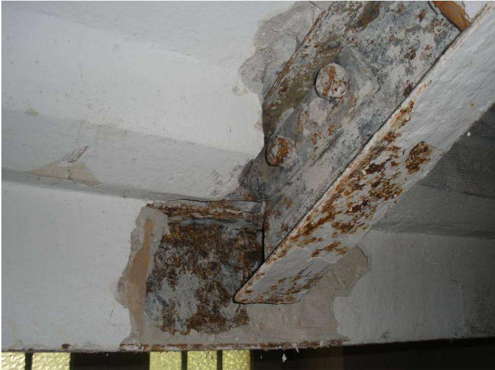
Figura 2-99 Trave portante della scala che sorregge la rampa tra pianerottolo e piano primo.
