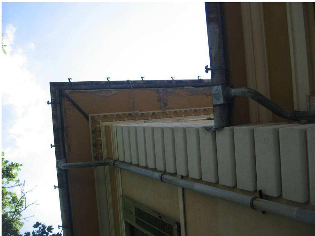
**Figura 1-7** Foto dello sporto di copertura in corrispondenza dell'angolo di edificio sopra il locale “Veranda”.
