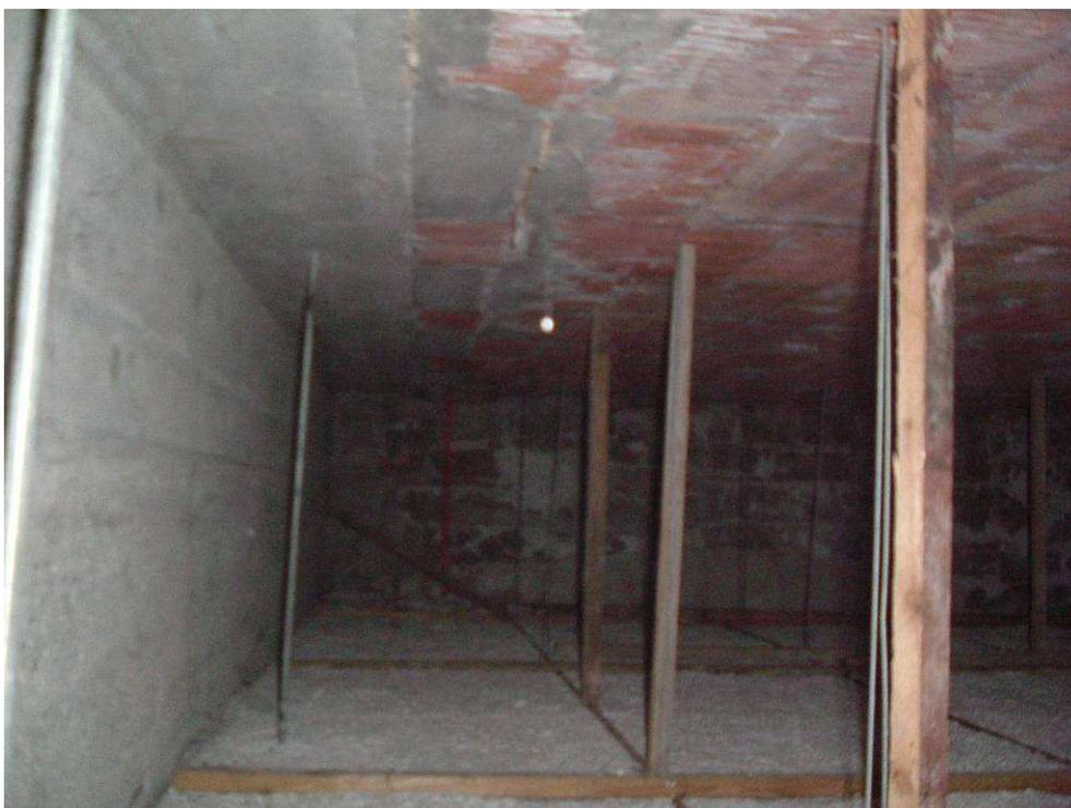
**Figura 6-12** Sondaggio a soffitto realizzato sull'intradosso del solaio di piano primo, da cui si rileva la presenza di un solaio latero cementizio sorretto da travi in c.a.
