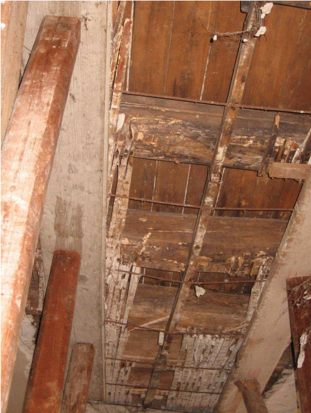
Figura 6-30 Rilievo del solaio di sottotetto in cui si evidenzia lo stato di degrado di questa porzione di edificio.
