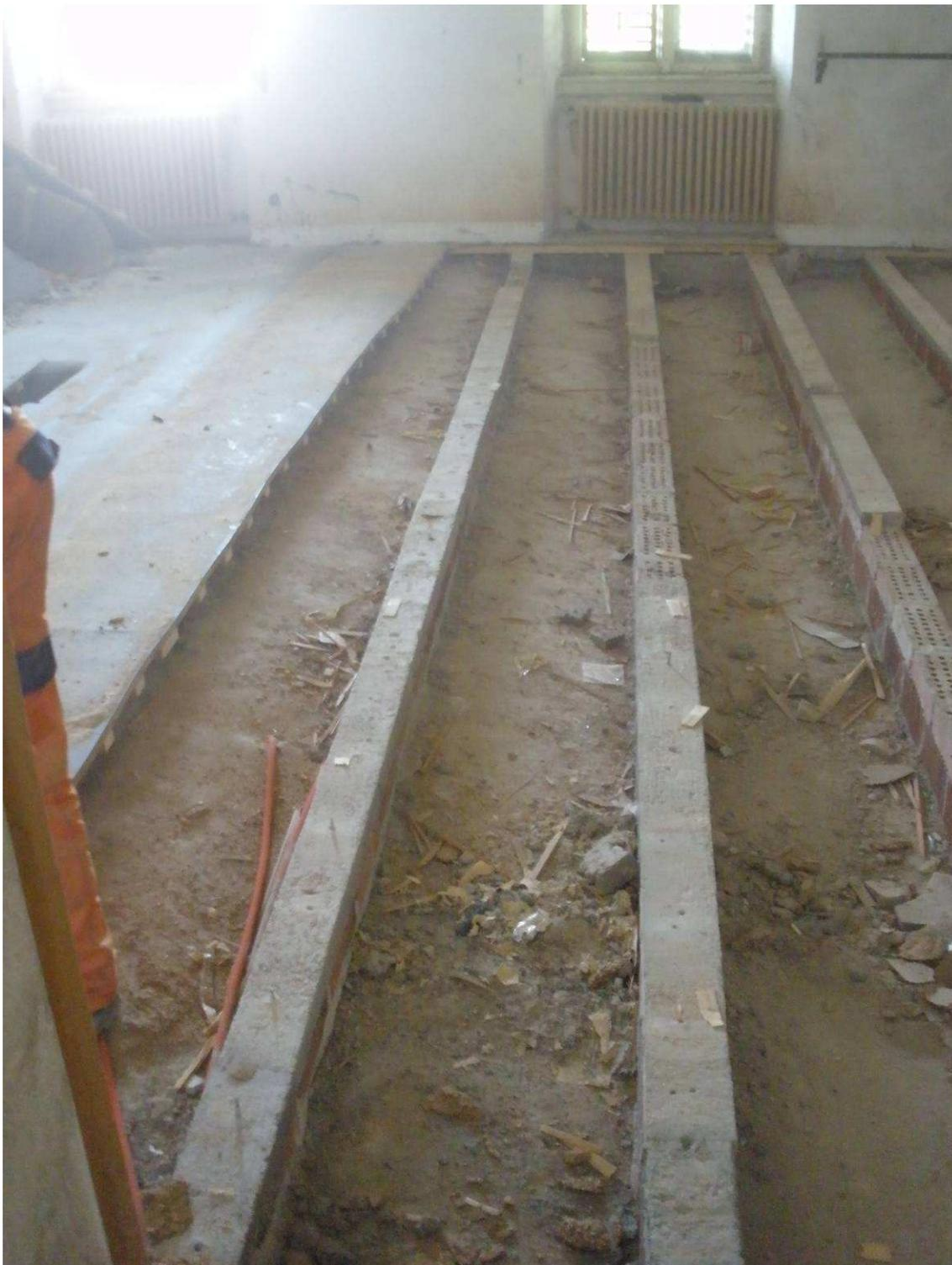
**Figura 2-47** In questa foto viene messa in mostra la presenza di muretti in muratura su cui è stato realizzato un orditura lignea a sostegno della pavimentazione.
