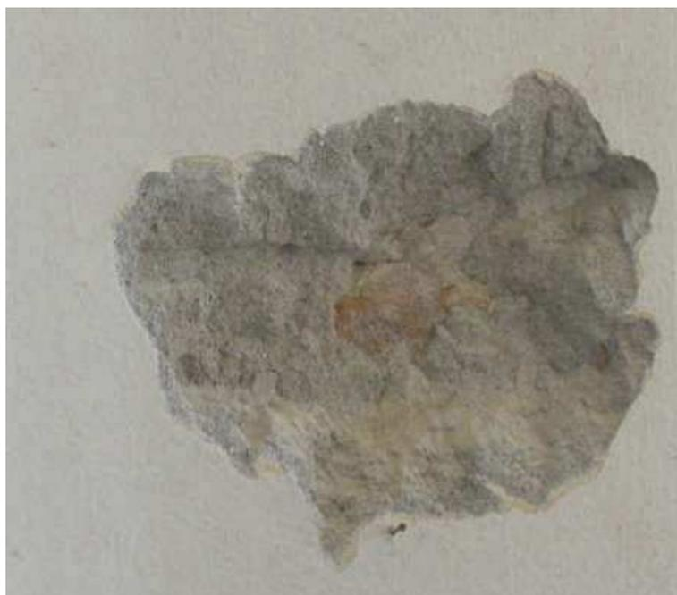
**Figura 2-69 Sondaggio a parete in cui si evidenzia la presenza di una parete in mattoni pieni con uno strato di intonaco.**
