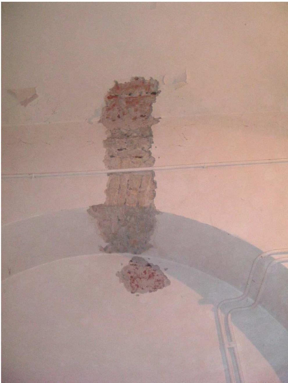
**Figura 6-17 Sondaggio a parete in cui si mette in luce la presenza di una parete in pietra e di un arco realizzato in mattoni pieni.**
