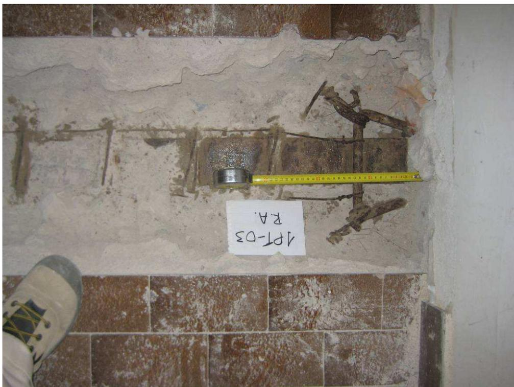
**Figura 2-119** Rilievo dell'estradosso del solaio Matrai tipo 1 del piano terra in corrispondenza della putrella. Si possono vedere la maniglia, le treccie e il passo dei fili.
