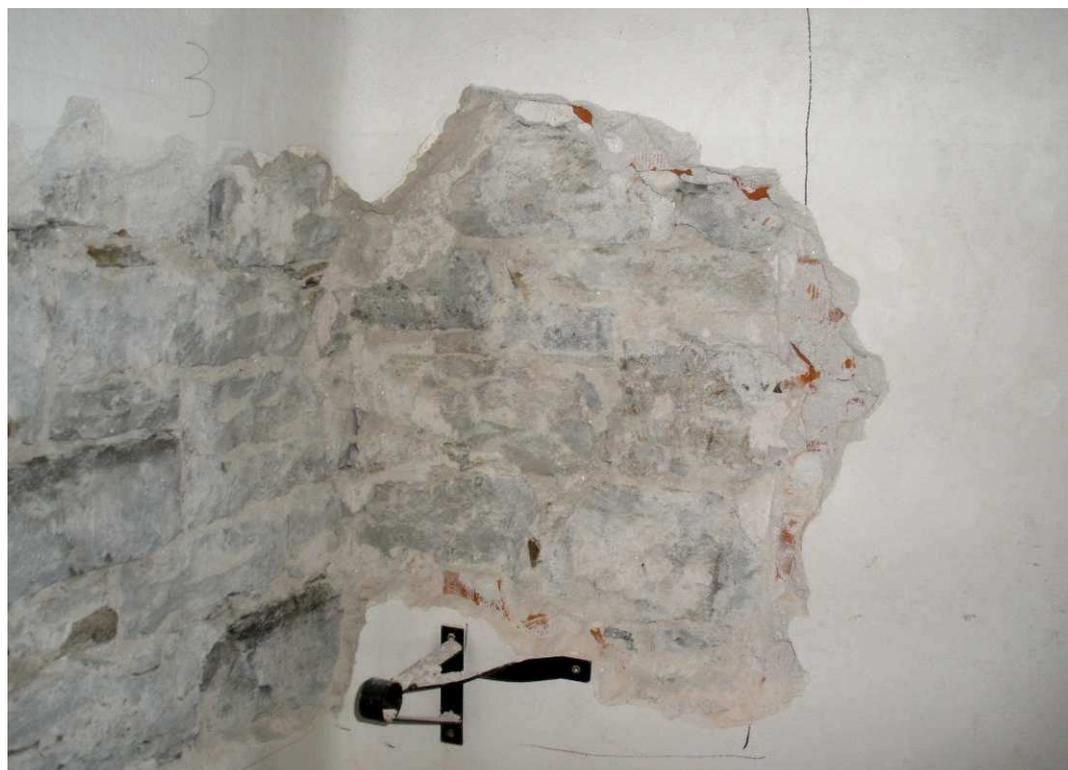
**Figura 2-39** Sondaggio a parete in cui si evidenzia nella parte sinistra 2 cm di intonaco e una parete di pietra, mentre la parete destra presenta uno strato esterno di 4/5 cm di intonaco con tracce di laterizio e una parete di pietra.
