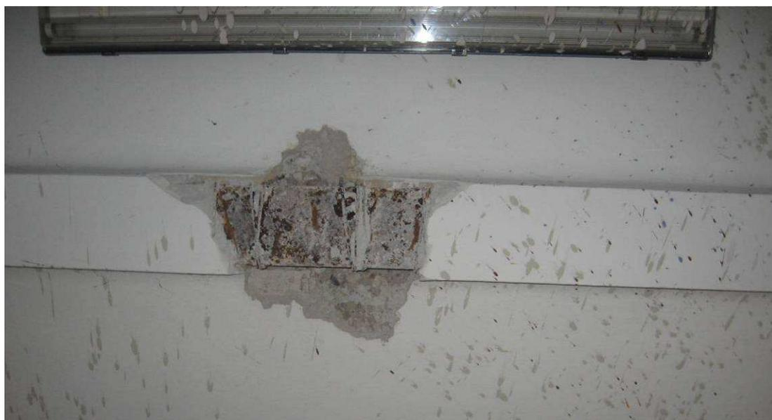
**Figura 2-6** Sondaggio a soffitto sul solaio di piano primo in cui si mette in luce la putrella ricalata, realizzata in corrispondenza di una tramezzatura in mattoni pieni, ora demolita. Anche in questo caso si possono notare le armature legate attorno alla putrella, tipiche del metodo costruttivo Matrai, utilizzato in questi solai.
