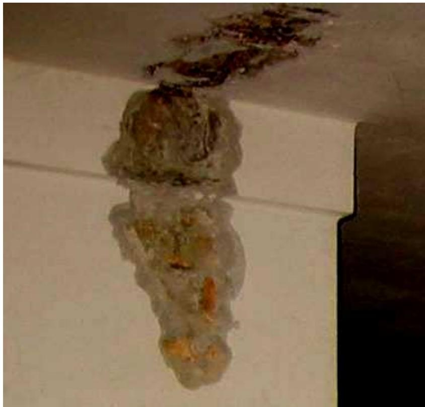
**Figura 2-15 Sondaggio a soffitto realizzato sul solaio di piano terra del locale "Refettorio" dai locali del piano interrato.**
