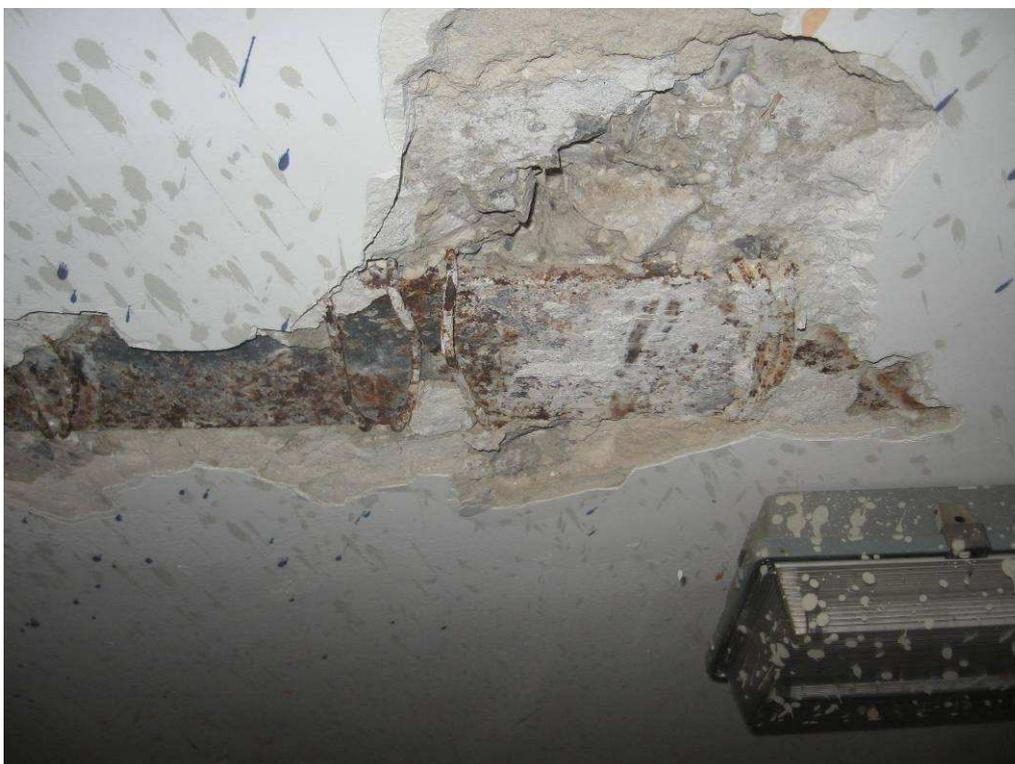
**Figura 2-9** Sondaggio a soffitto sul solaio di piano primo in corrispondenza delle putrelle. Si possono notare le armature della soletta legate alla putrella come previste dal metodo Matrai.
