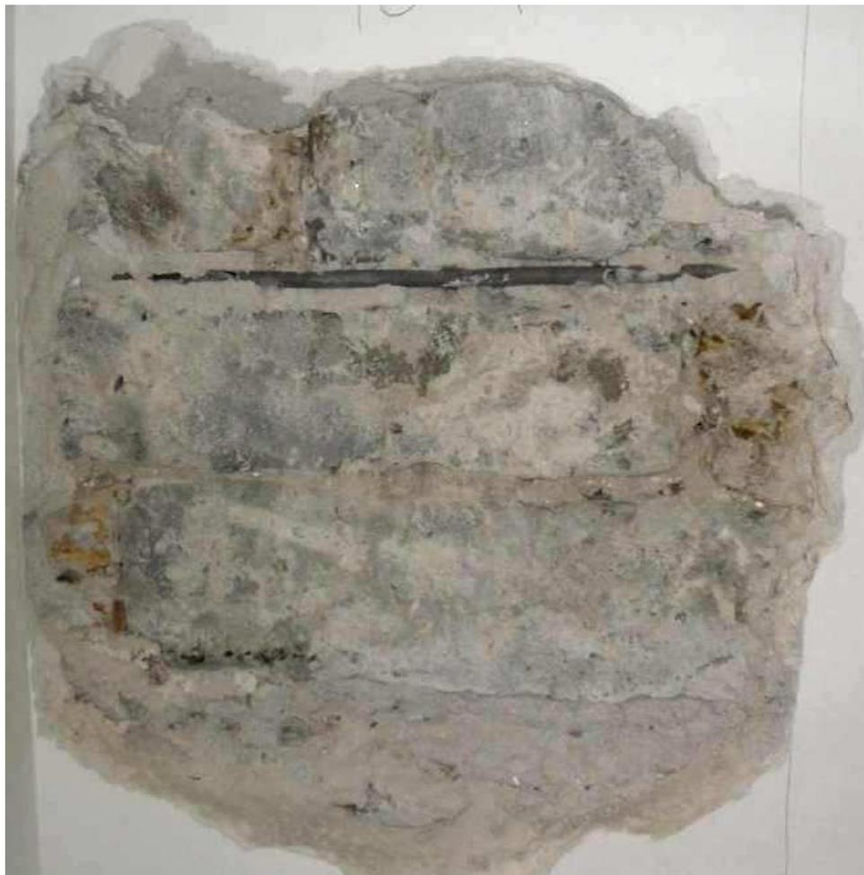
Figura 2-56 SONDAGGIO 10A in cui è presente una parete in pietra squadrata ed un rivestimento di intonaco.
