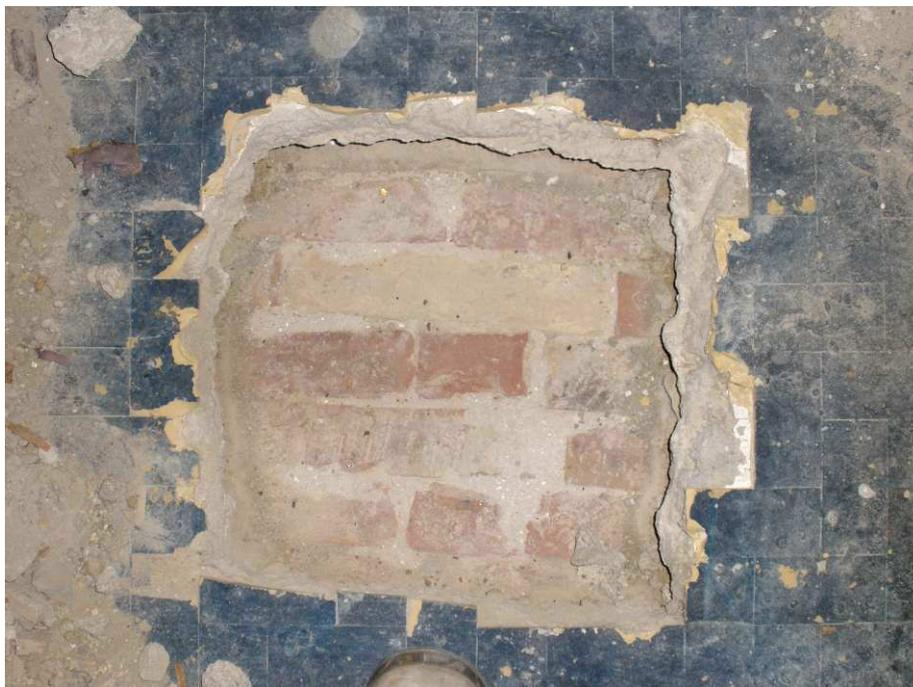
**Figura 2-104 Sondaggio a pavimento sul solaio di piano terra in corrispondenza della mezzeria delle volte in muratura del corridoio.**
