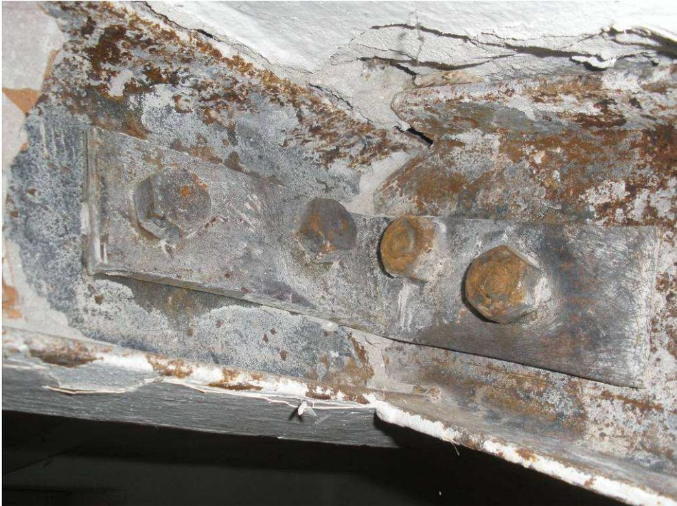
**Figura 2-103 Collegamento tra elementi portanti della scala.**
