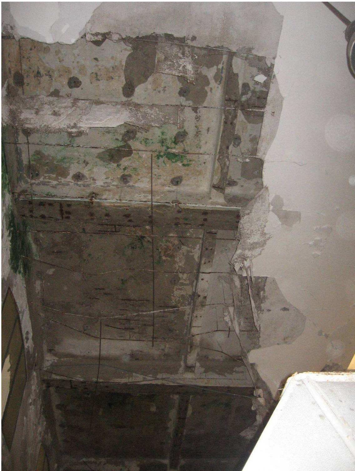
**Figura 6-23** Rilievo della copertura del locale cucine in cui la caduta del controsoffitto mette in evidenza la presenza di un solaio latero cementizio da sbordano le travi principali e secondarie.
