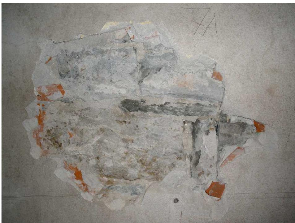
Figura 2-44 SONDAGGIO 7A - parete in cui si evidenzia una sezione di collegamento tra la parete in pietra (con uno strato di intonaco 3cm) e la parete in mattoni pieni (strato di intonaco 3cm).
