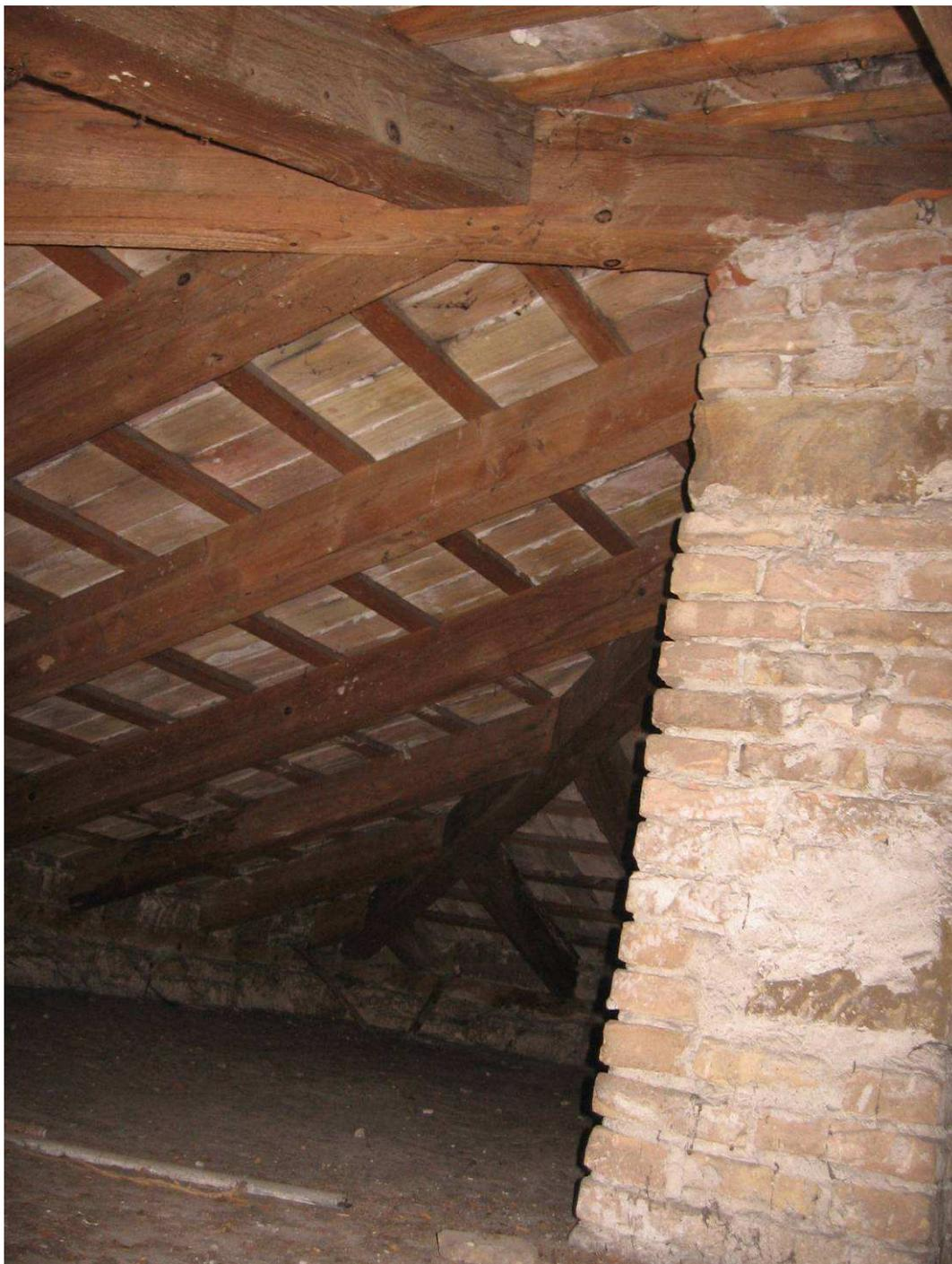
**Figura 6-27 Rilievo struttura di sottotetto sostenuta da un pilastro in muratura.**
