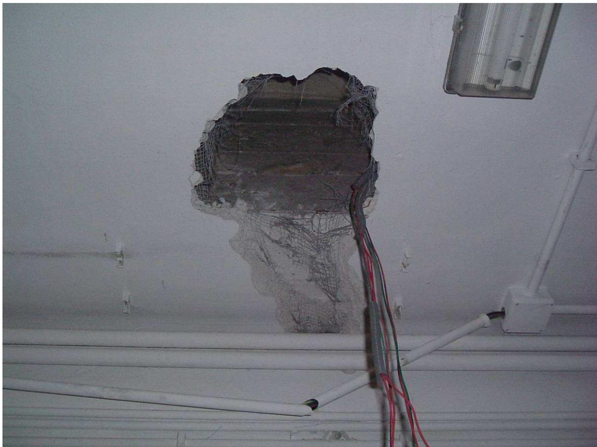
Figura 6-15 Sondaggio a solaio da cui è stato rilevata la presenza di una trave in c.a.
