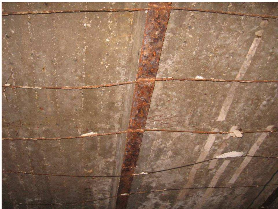
**Figura 2-33** Solaio di copertura del locale "Dormitorio" posto al piano primo, in cui la caduta del controsoffitto mette in evidenza le putrelle e le barre che sostenevano il cartongesso.
