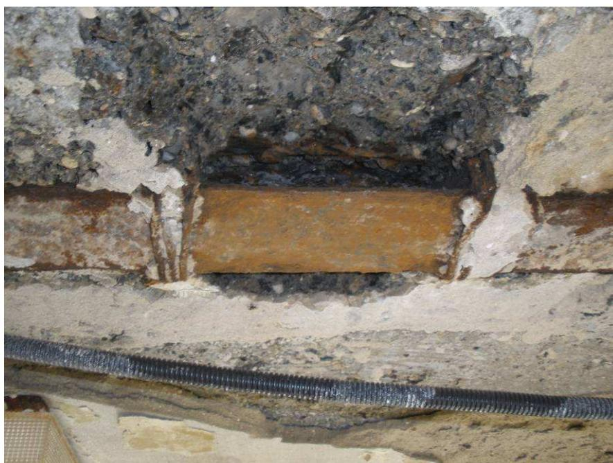
**Figura 2-66 SONDAGGIO 16B - Sondaggio a soffitto in cui si mette in luce la presenza di una putrella di base 8 cm circa e a cui sono collegate le barre metalliche di armatura della solette. La disposizione e la modalità di collegamento confermano che il solaio è stato realizzato secondo il brevetto Matrai.**
