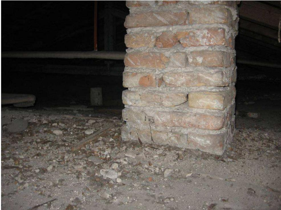
**Figura 6-29** Rilievo della presenza di un pilastro di appoggio per la struttura lignea della copertura.
