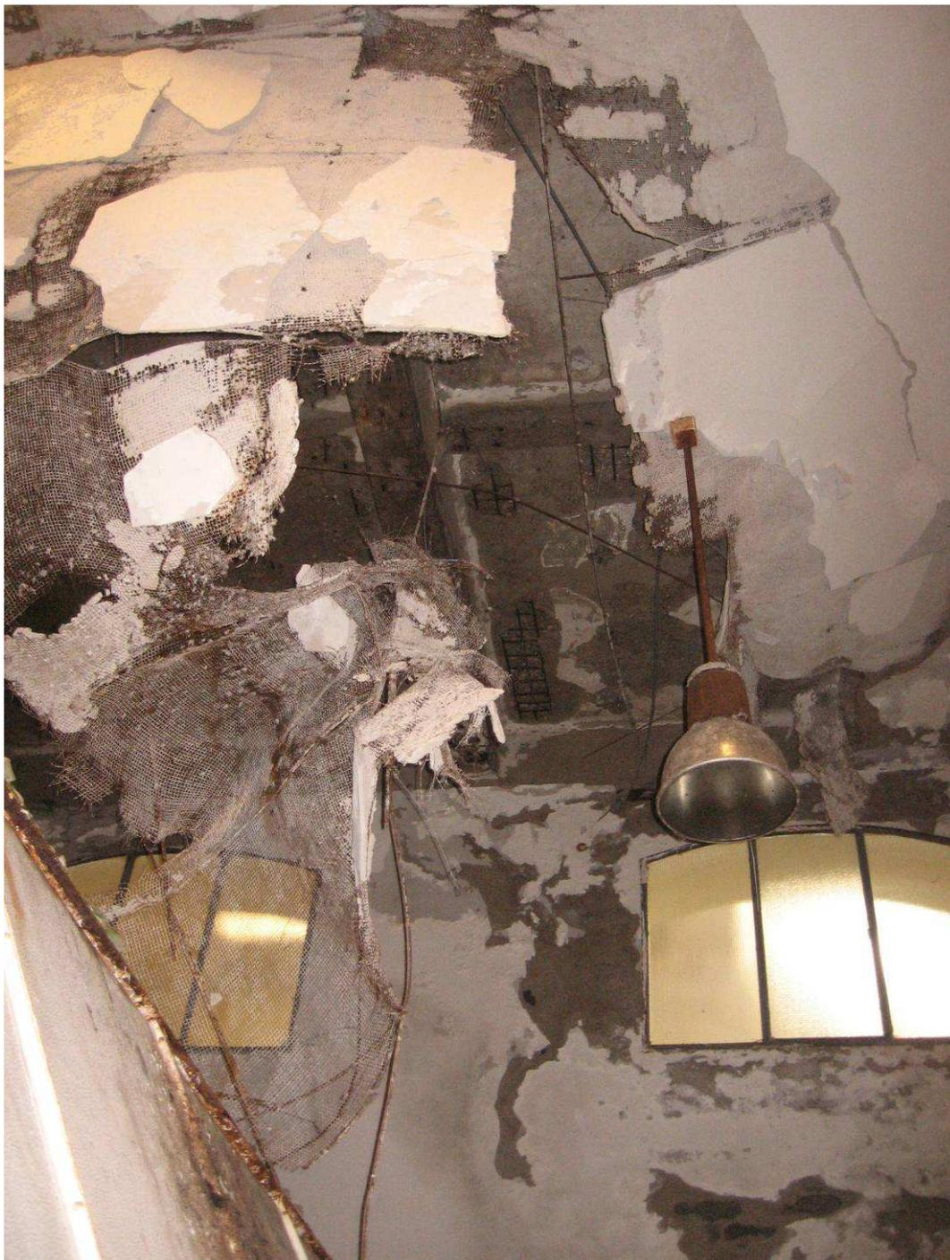
**Figura 6-24** Rilievo del cattivo stato di conservazione del locale cucina e della parziale caduta dei controsoffitti.
