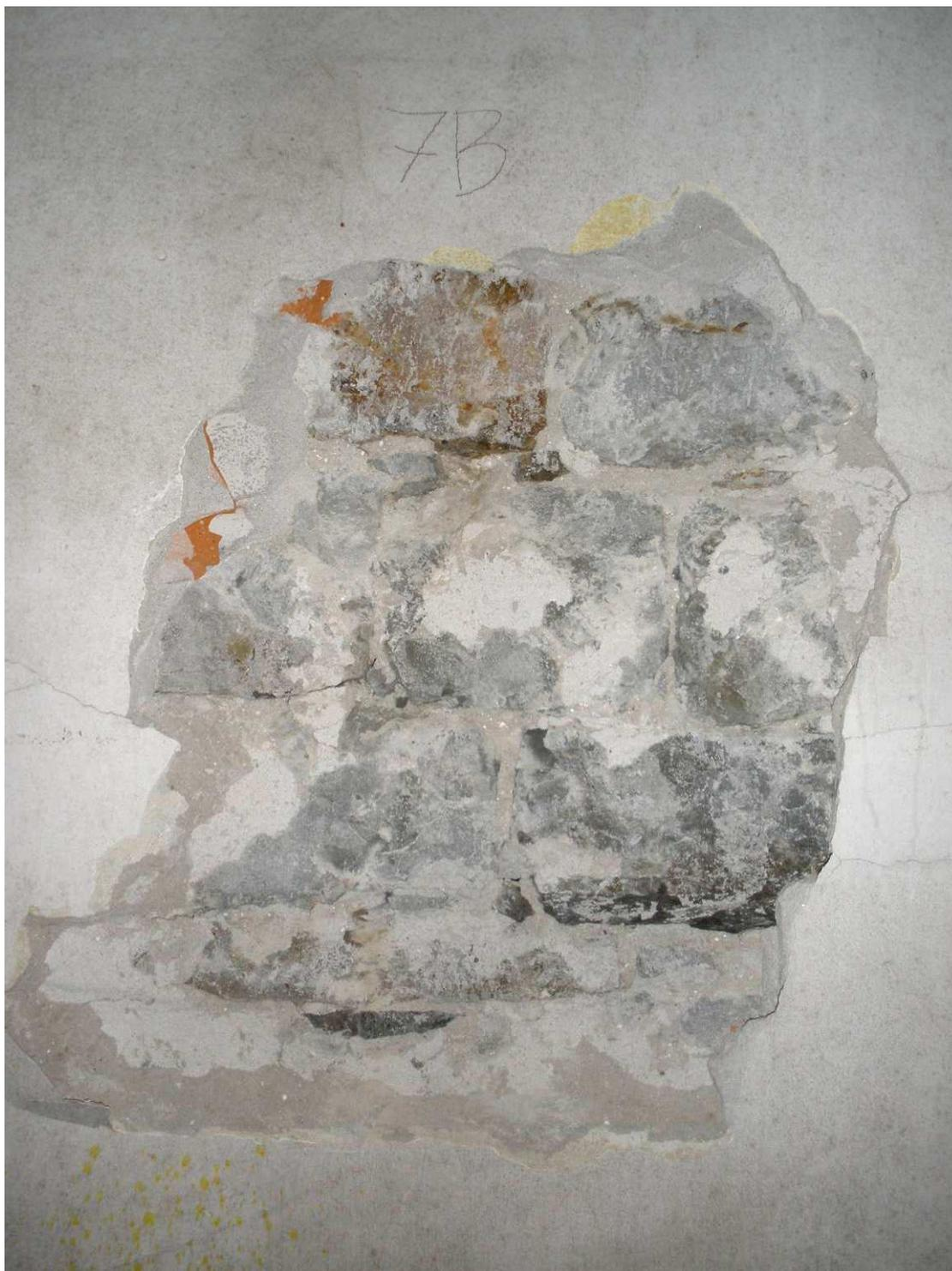
**Figura 2-45 SONDAGGIO 7B - sondaggio a parete in cui si evidenzia una parete in pietra ed intonaco con fogli di laterizio.**
