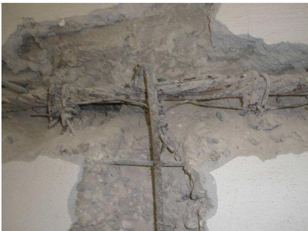
**Figura 2-73** Sondaggio sulla parete esterna del locale "Soggiorno" per individuare l'originario collegamento del solaio di piano primo, realizzato secondo il brevetto Matrai, e successivamente demolito.
