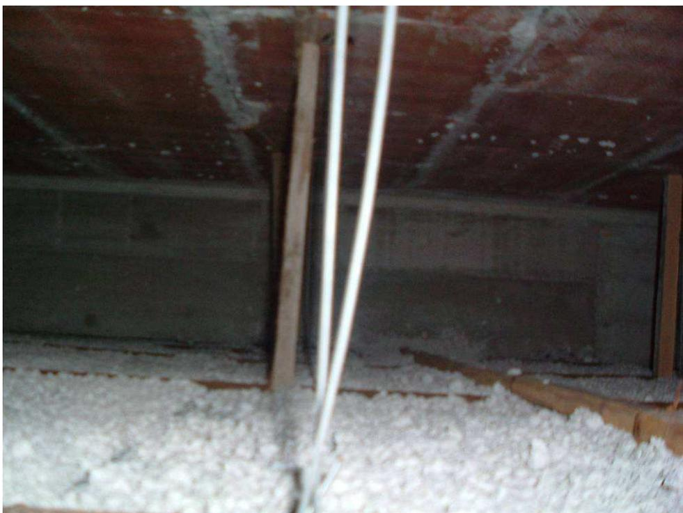
**Figura 6-6 Sondaggio a soffitto in cui si mette luce la realizzazione di un controsoffitto sorretto da travetti lignei appesi alle pignatte del solaio latero cementizio di piano primo.**
