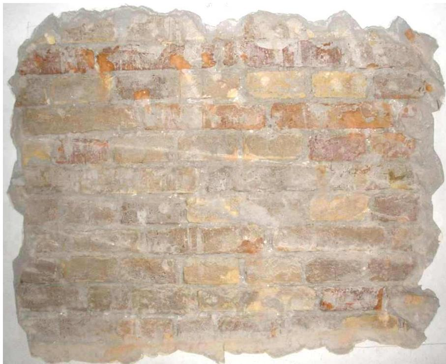
**Figura 2-62 Sondaggio a parete in cui evidenzia la presenza di una parete in mattoni pieni ed uno strato di intonaco esterno di 7,5 cm.**
