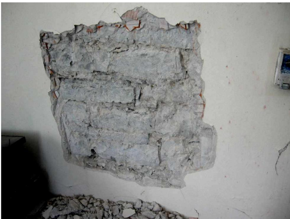
Figura 2-31 Sondaggio a parete in cui si evidenzia la presenza di una parete in pietra con intonaco.
