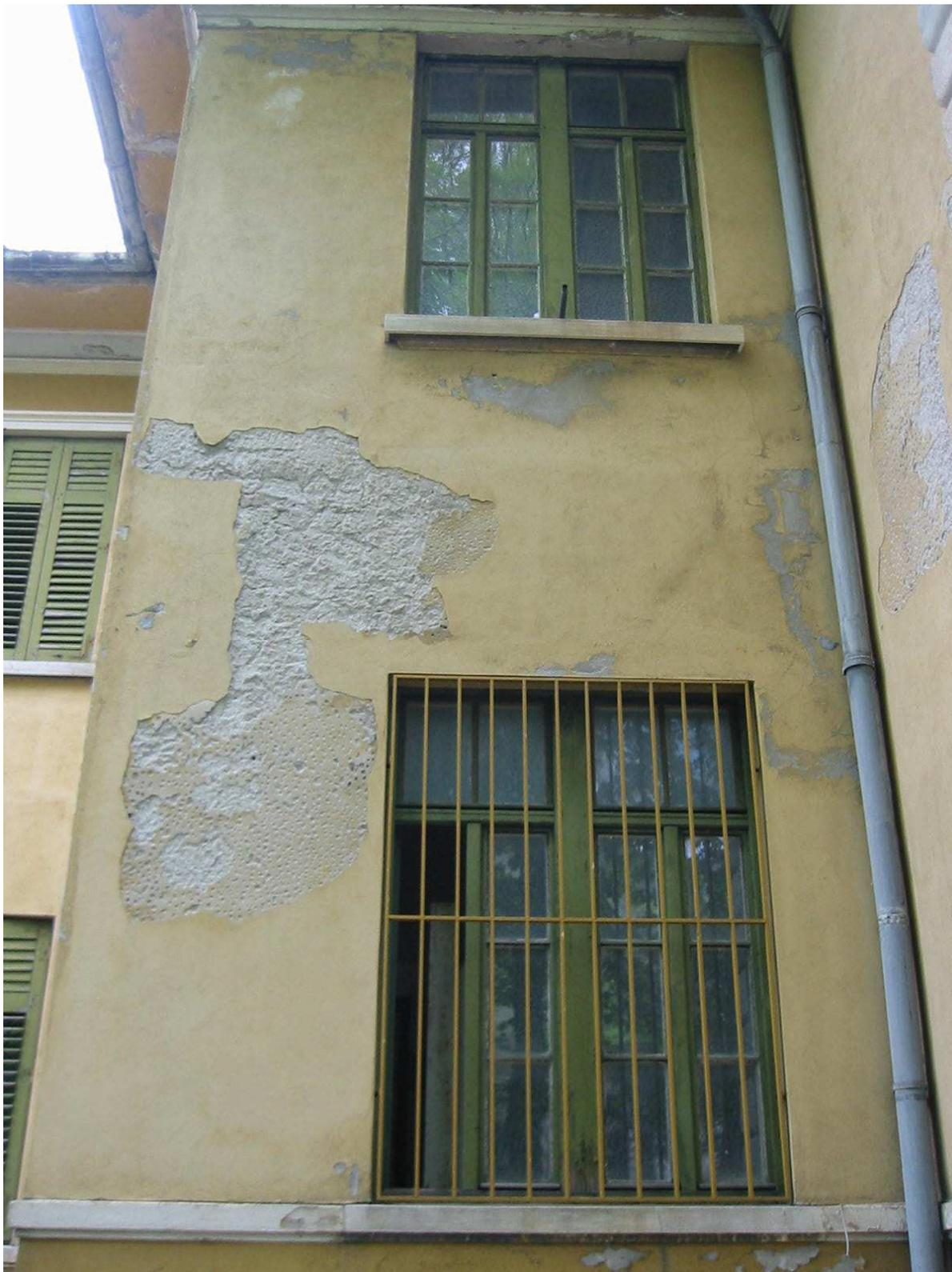
**Figura 1-11** Foto di un paramento esterno dell’edificio in cui la caduta dell’intonaco permette di vedere la preparazione del sottofondo.
