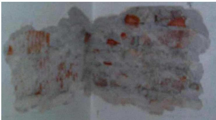
**Figura 6-5 Sondaggio a parete in cui si evidenzia la presenza di una parete in mattoni pieni e una parete di mattoni doppio UNI.**
