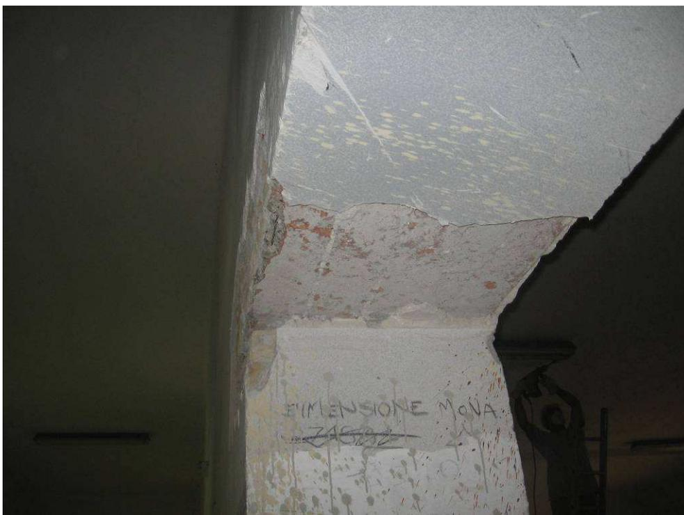
Figura 2-27 Sondaggio sull'architrave che mette in luce la presenza di un architrave in c.a. realizzato durante gli interventi del 1966.
