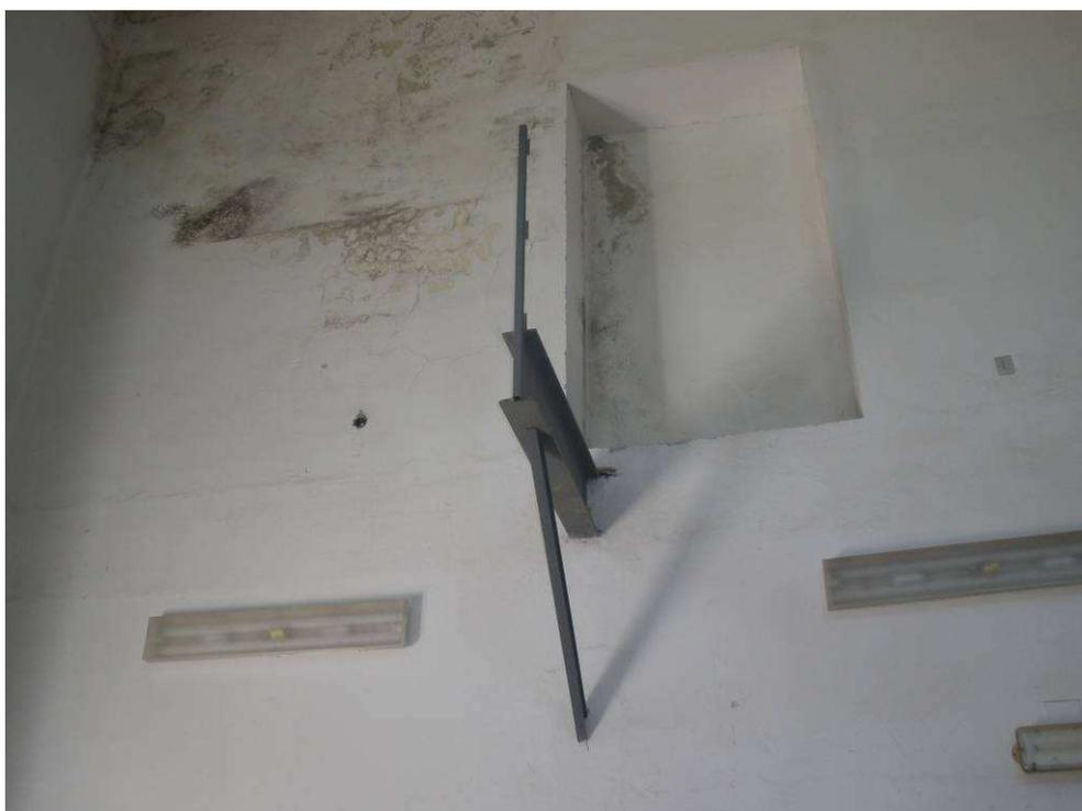
**Figura 2-72 Particolari delle putrelle rimaste e loro collegamento**
