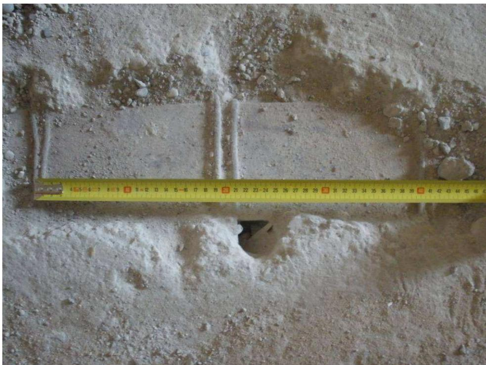
**Figura 2-48** Putrella portante presente nella soletta di solaio di piano primo, secondo la tipologia Matrai, ed in cui si possono ritrovare anche le armature della soletta legate alla putrella.
