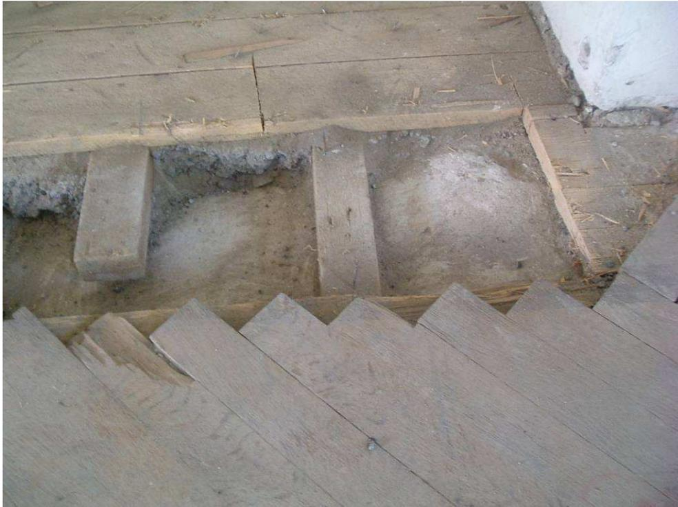
Figura 2-87 Stratigrafia della parte superiore del solaio.
