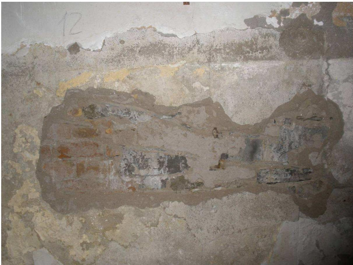
**Figura 2-59 SONDAGGIO 12A - Sondaggio a parete in cui si evidenzia la presenza di una sezione di collegamento tra la parete in pietra squadrata e la parete in mattoni pieni. In entrambi i casi è presente uno strato esterno di intonaco di circa 3-4 cm.**
