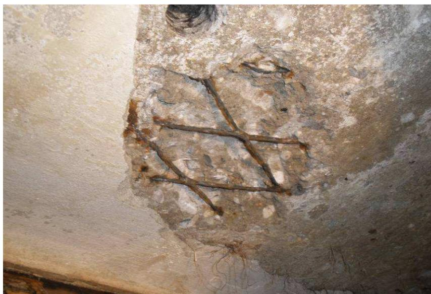
**Figura 2-83 Sondaggi realizzato sul solaio di copertura in cui si mette in luce la presenza di una rete metallica nella soletta.**
