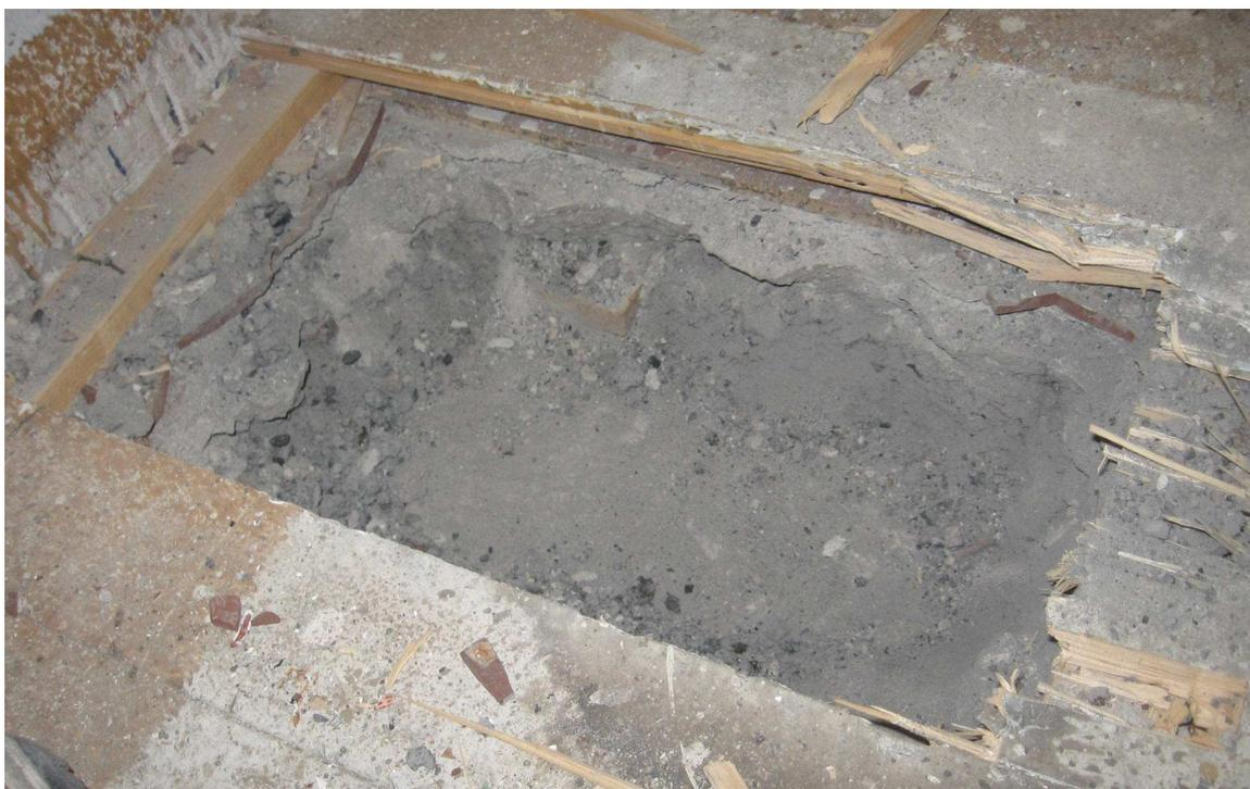
**Figura 2-2** Sondaggio realizzato a pavimento sul solaio di piano terra da cui si mette in luce una soletta di calcestruzzo armata secondo il metodo Matrai e la presenza dell'originaria pavimentazione in ceramica e della recente pavimentazione lignea.
