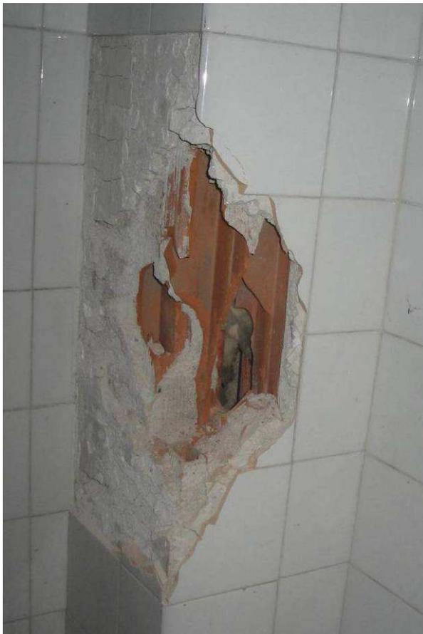
**Figura 6-18 Sondaggio a pareti da cui si evince la presenza di una canalizzazione realizzata con mattoni forati.**
