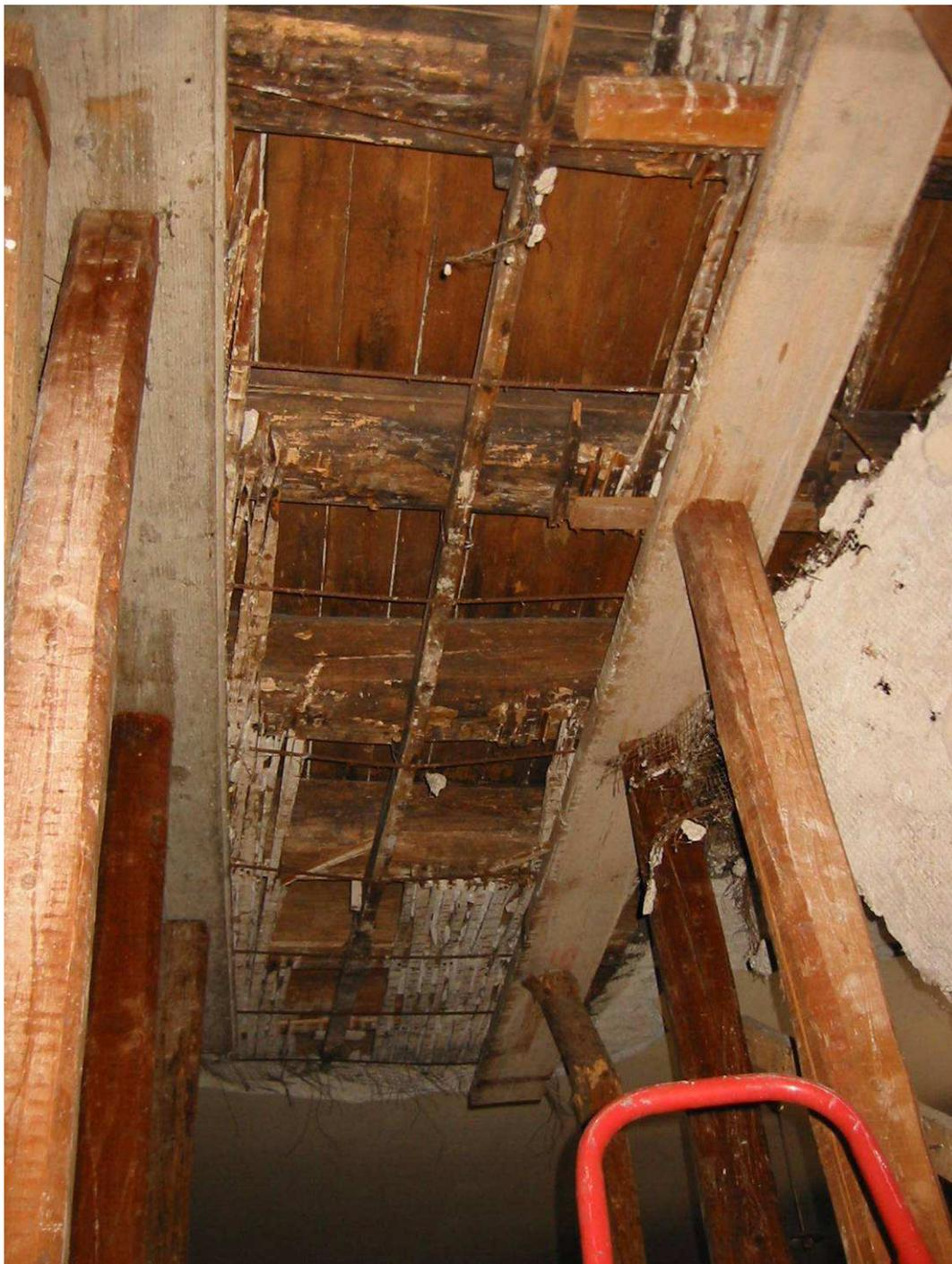
**Figura 6-31 Rilievo del solaio di sottotetto in cui si evidenzia lo stato di degrado di questa porzione di edificio.**
