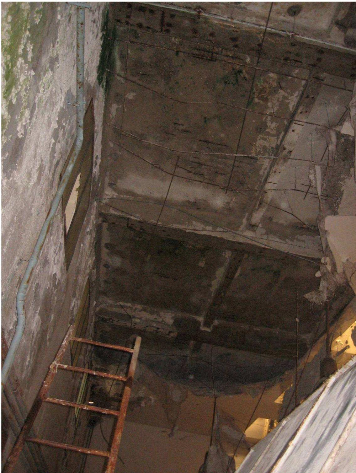
**Figura 6-22 Rilievo della soletta e delle travi in c.a. della copertura del locale cottura.**
