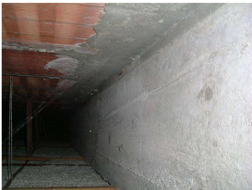
**Figura 6-8** Sondaggio a soffitto realizzato sull'intradosso del solaio di piano primo in cui si mette in luce un solaio latero cementizio.
