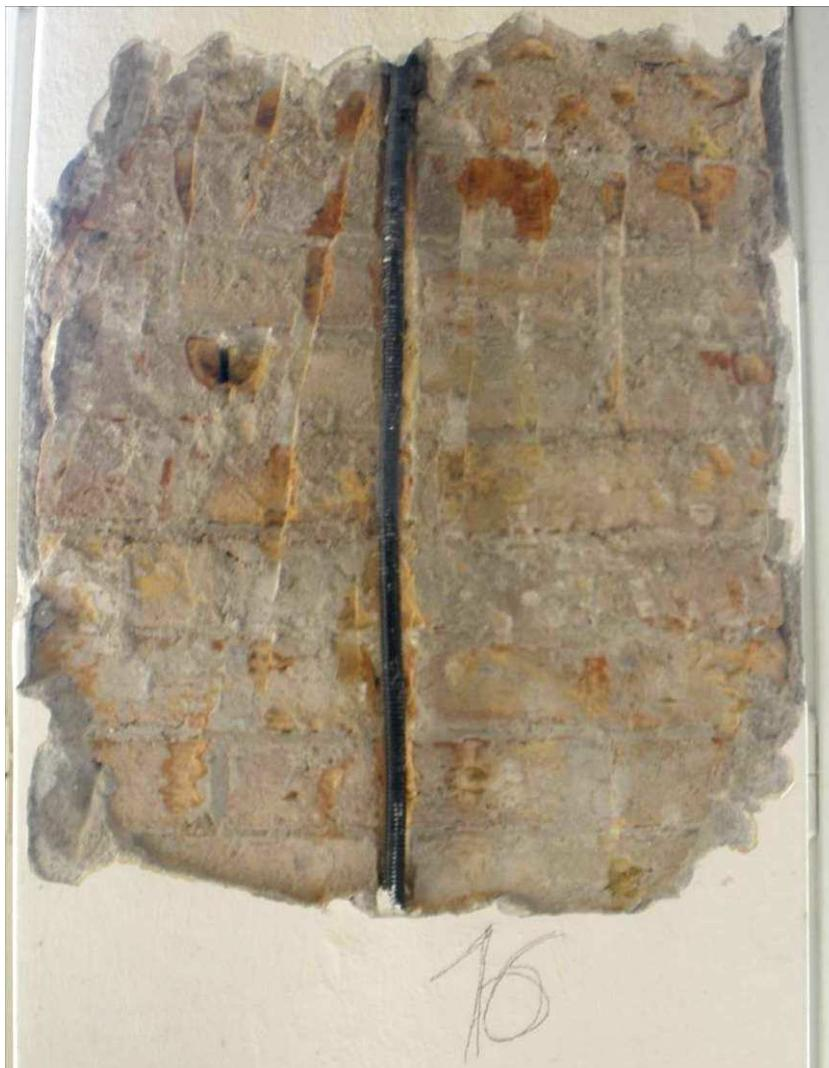
**Figura 2-64 SONDAGGIO 16A - Sondaggio a parete da cui si evidenzia la presenza di una parete di mattoni pieni con uno strato di intonaco di 1cm.**
