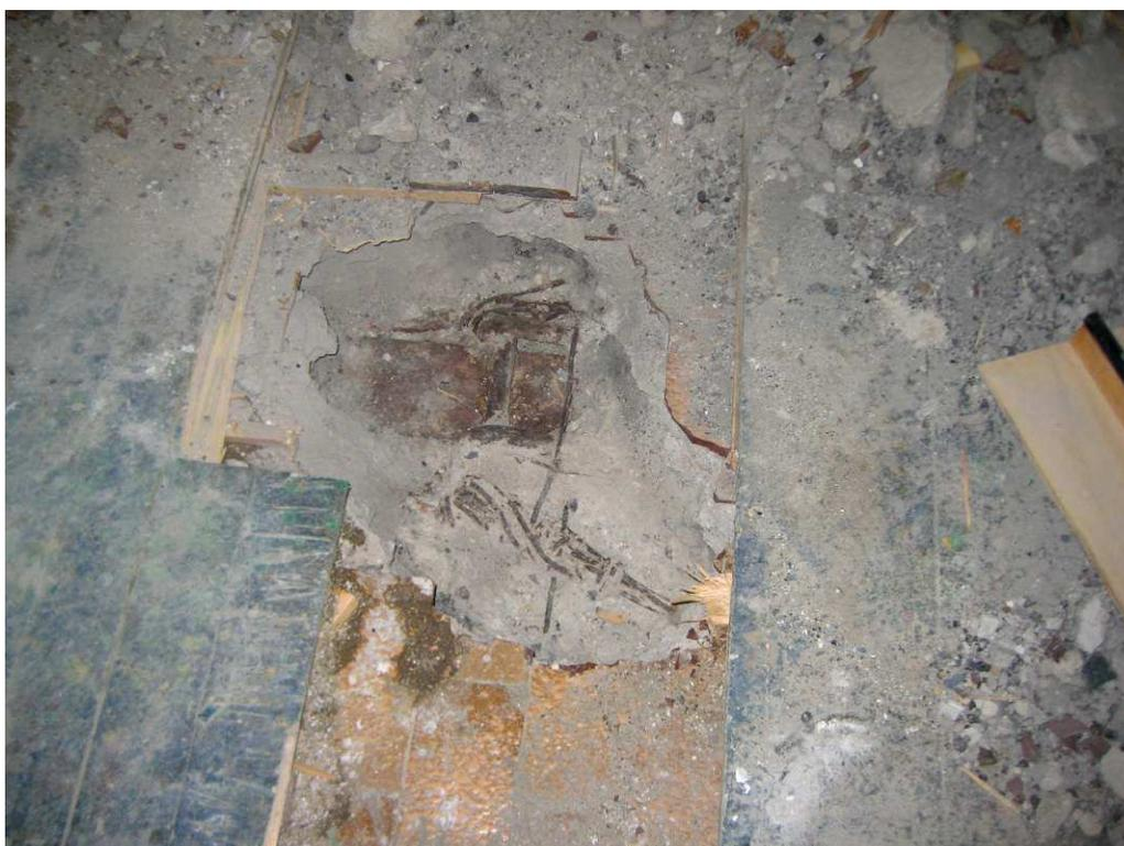
Figura 2-123 Saggio sul solaio Matrai tipo 2 al Piano Terra.
