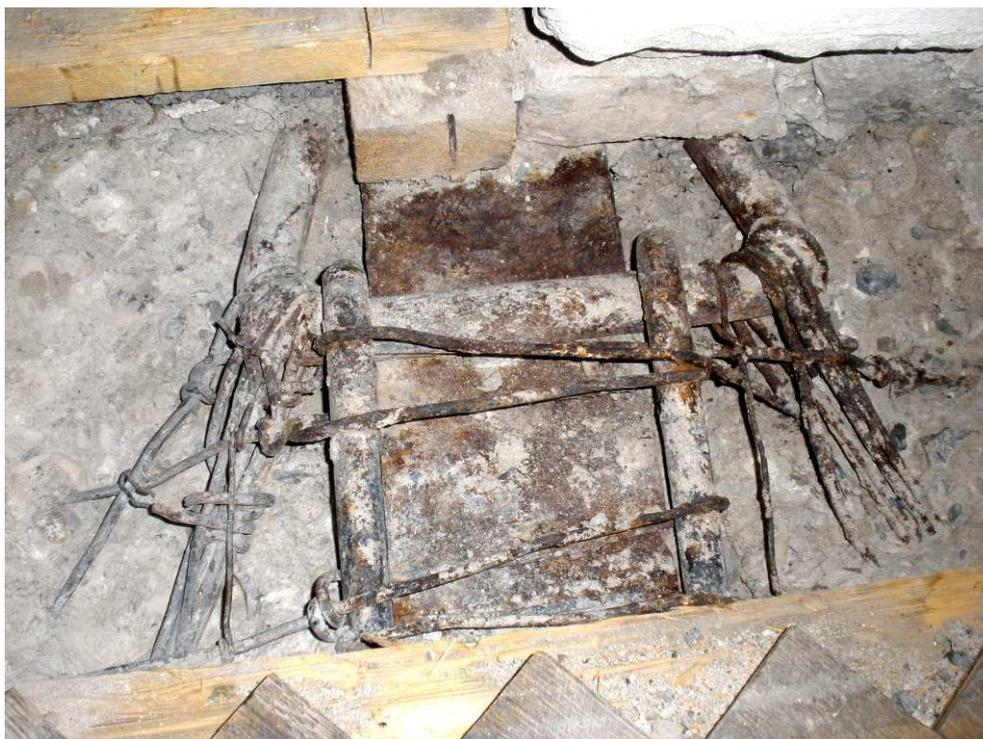
Figura 2-89 Sondaggio a pavimento realizzato sull'estradosso del solaio di piano primo nel locale "Dormitorio". In questo sondaggio si mette in luce la parte superiore del collegamento tra le barre di armatura e la trave metallica portante.
