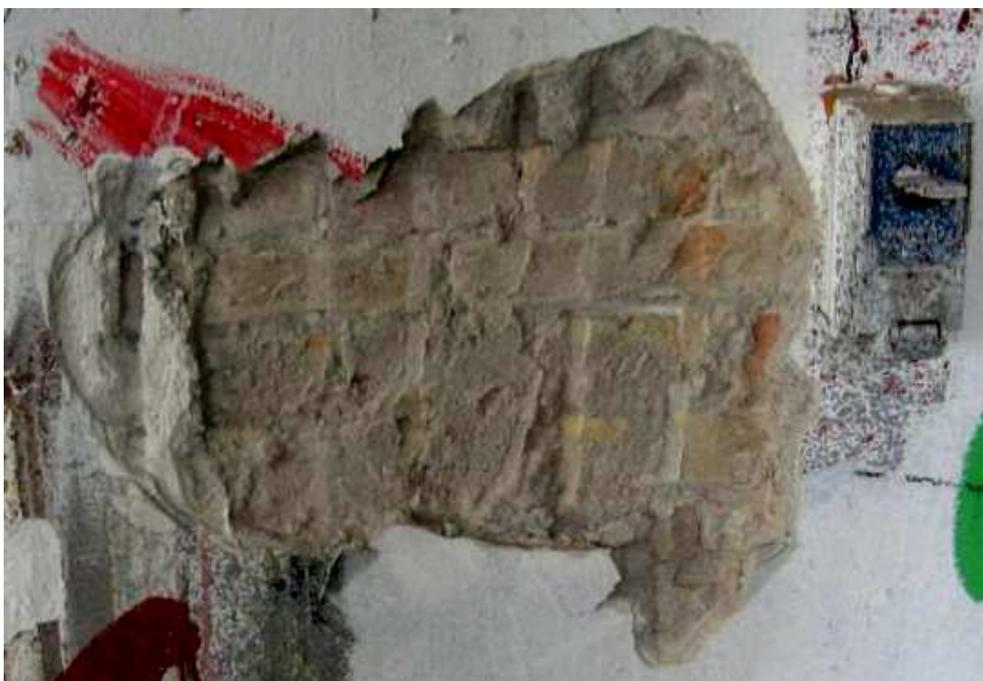
Figura 2-32 Sondaggio a parete che mette in luce una parete realizzata in mattoni pieni e intonaco.
