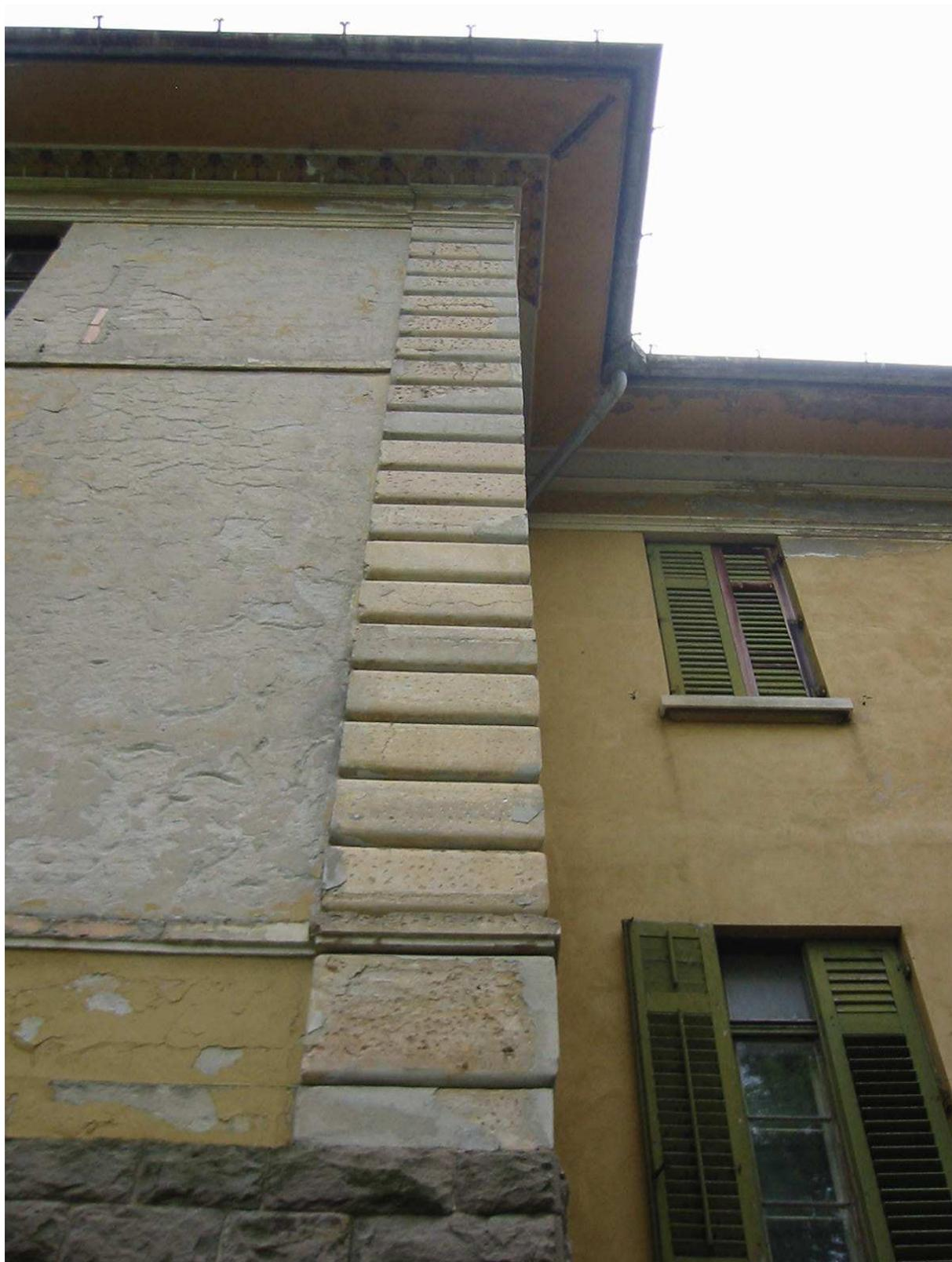
**Figura 1-10** Foto di un angolo dell’edificio in cui si nota la putrella che sorregge l’angolo della copertura.
