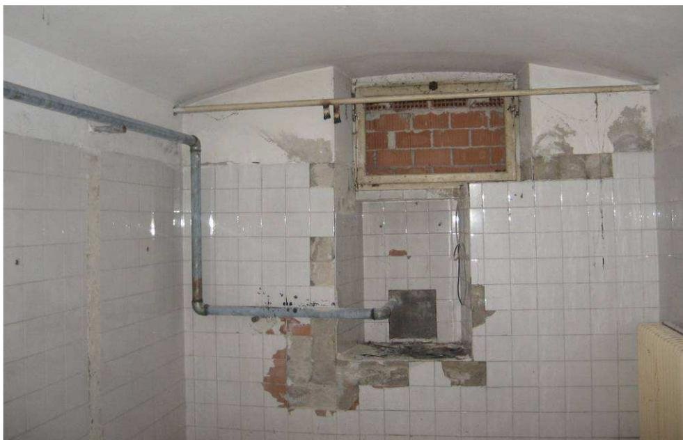
**Figura 2-22 RILIEVO R.A.11.C-** Questo locale situato al piano interrato presenta una copertura realizzata con una volta in muratura.
