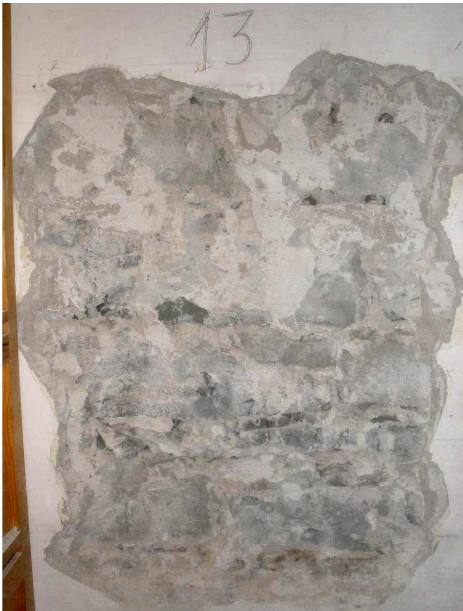
**Figura 2-61 Sondaggio a parete in cui evidenzia la presenza di una parete in pietra ed uno strato di intonaco esterno di 3-4 cm.**
