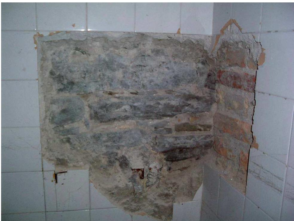
Figura 6-14 Sondaggio a parete da cui si evidenzia la presenza di una parete di pietra e una parete di mattoni pieni.
