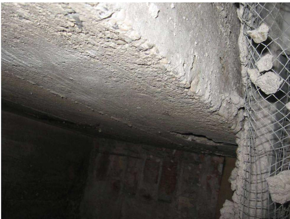
**Figura 6-20 Sondaggio a soffitto da cui si evince la presenza di una trave in c.a. e solaio latero cementizio completato da controsoffitto.**
