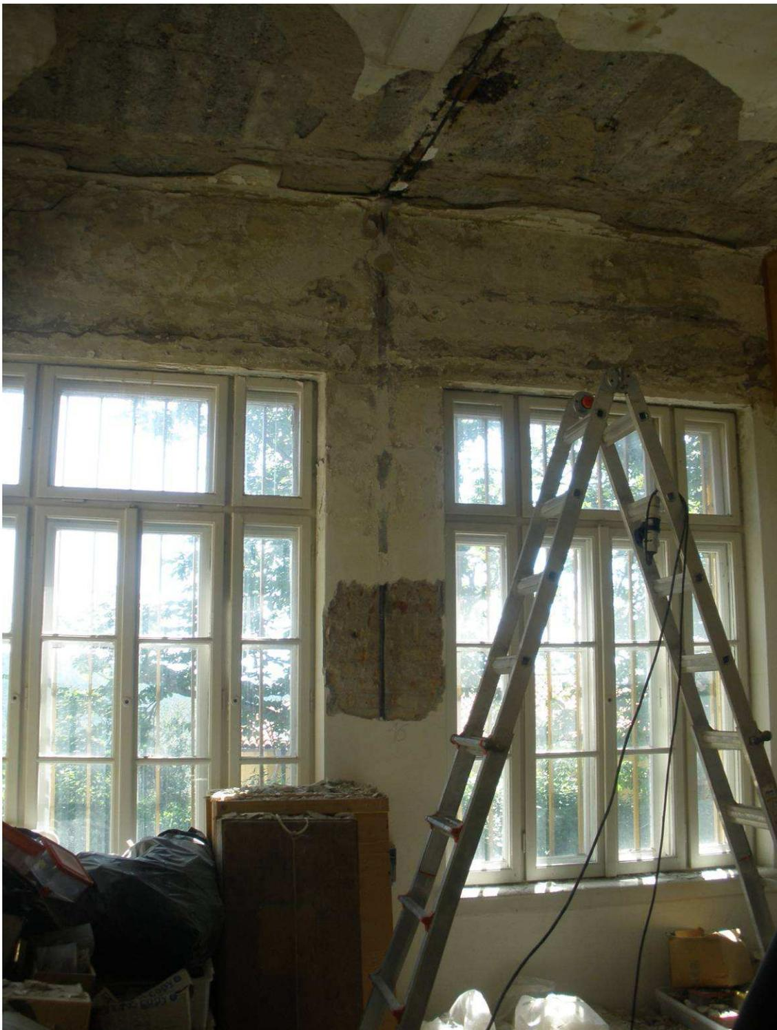
**Figura 2-65 Sondaggio a parete e sondaggio a soffitto in cui si mette in luce la conformazione del solaio di piano primo.**
