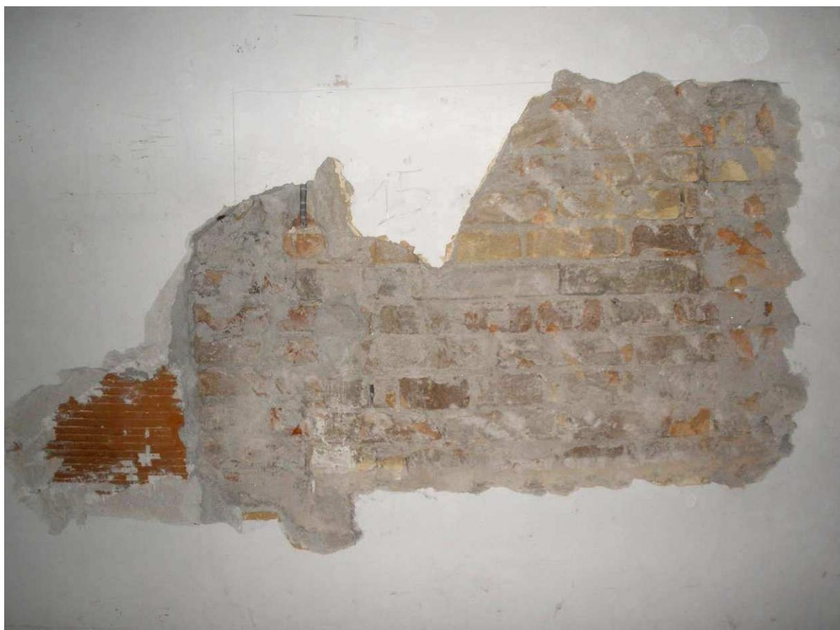
**Figura 2-63 Sondaggio a parete in cui evidenzia la presenza di una parete in mattoni pieni rivestita da uno strato di intonaco, affiancata da una parete di tamponamento.**
