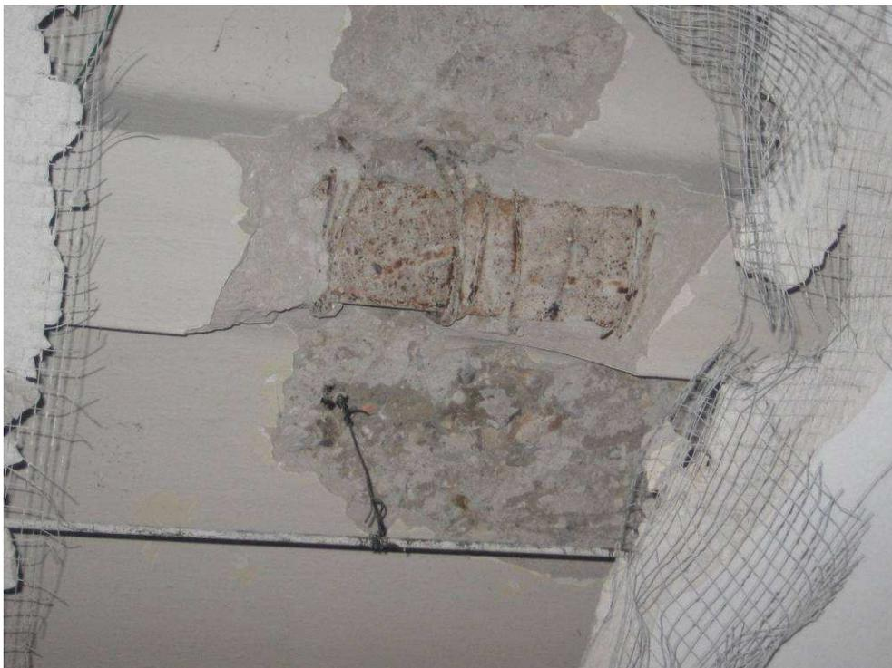
**Figura 2-13 Sondaggio a soffitto realizzato sul solaio di piano terra nel locale interrato. Si mette in luce la presenza di un solaio in calcestruzzo tipo Matrai e della presenza di putrelle metalliche. Le armature della soletta sono collegate alla putrella a passi differenti.**
