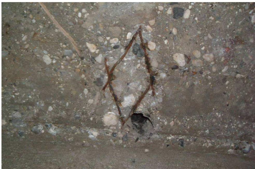
**Figura 2-49** SONDAGGIO 7D – Sondaggio sul solaio di copertura del locale "Dormitorio" posto al piano primo, realizzato su un solaio di calcestruzzo armato a soletta piena tipo Monier.
