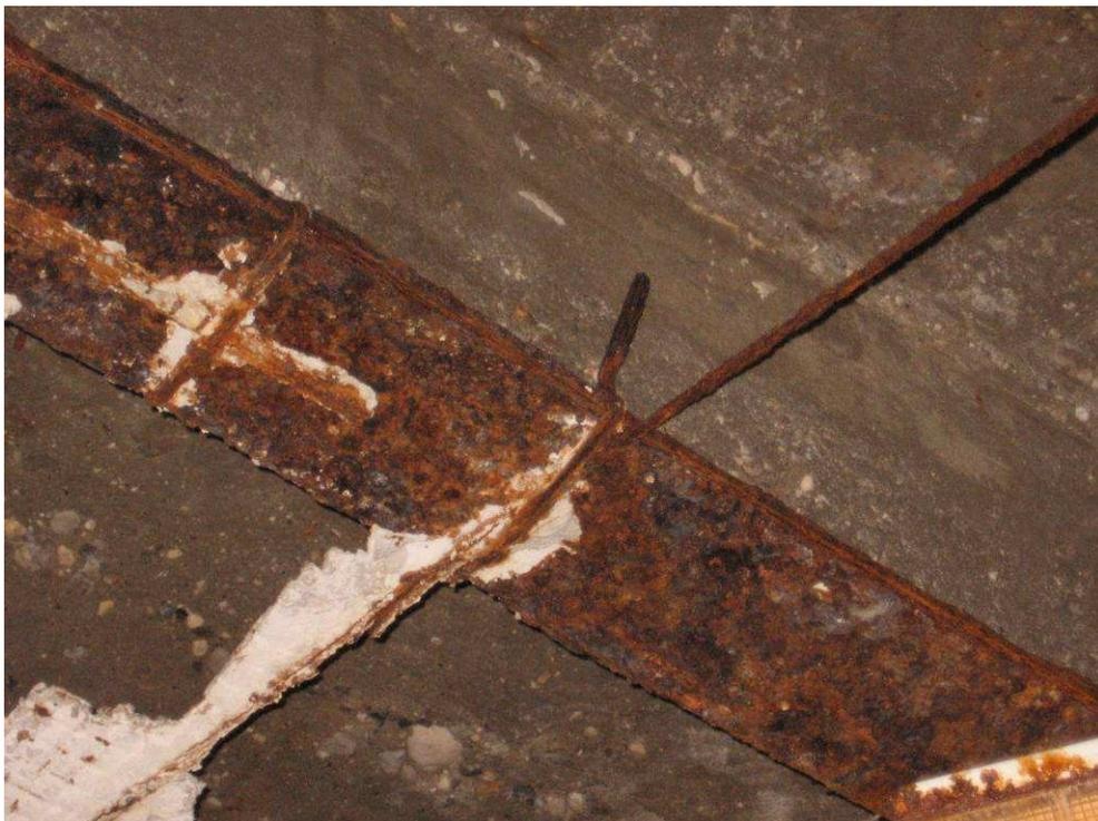
**Figura 2-35 Particolari di collegamento delle armature alle putrelle.**
