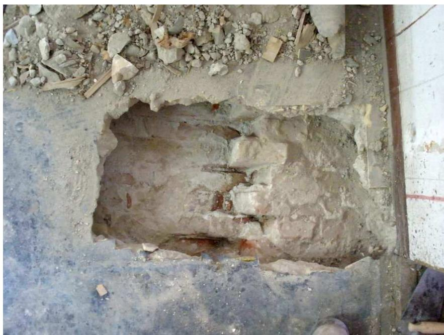
**Figura 2-105 Sondaggio a pavimento sul solaio di piano terra in corrispondenza dell'appoggio delle volte in muratura del corridoio.**
