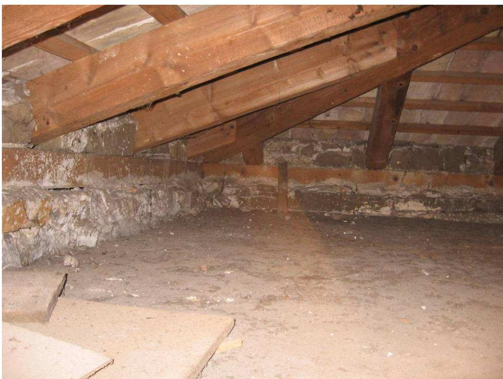
**Figura 6-28 Rilievo della copertura, in cui si può notare la presenza di un dormiente ligneo su cui poggiano le travi della copertura**
