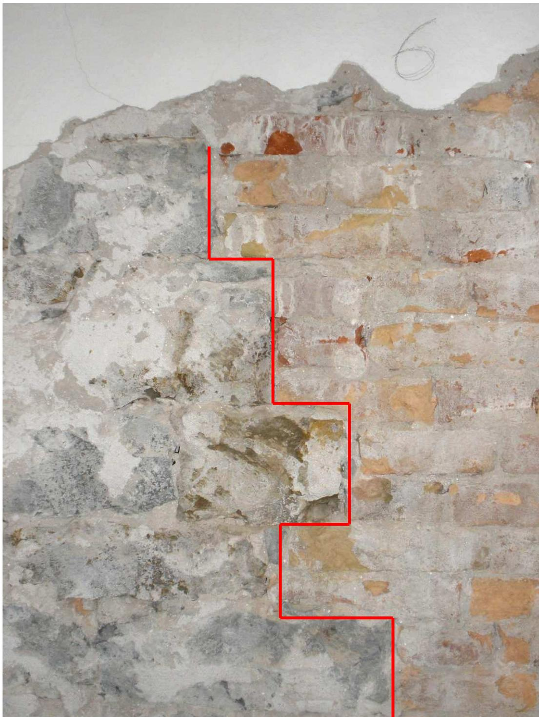
Figura 2-43 Sondaggio a parete da cui si evidenzia una sezione di collegamento tra la parete in pietra ( con uno strato di intonaco 1,5cm) e la parete in mattoni pieni (strato di intonaco 2,5cm).
