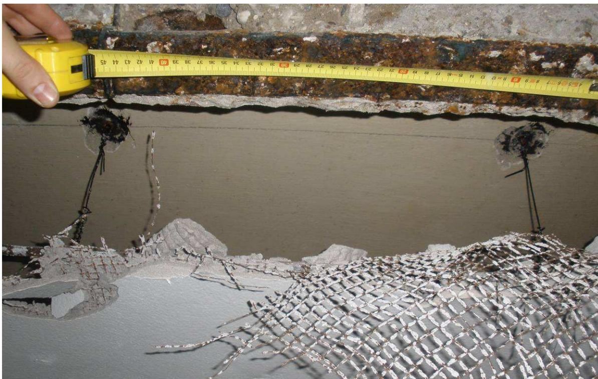
**Figura 2-79** Sondaggio sul solaio di copertura del corridoio, in cui si è messa in luce una putrella e la struttura di sostegno del controsoffitto.
