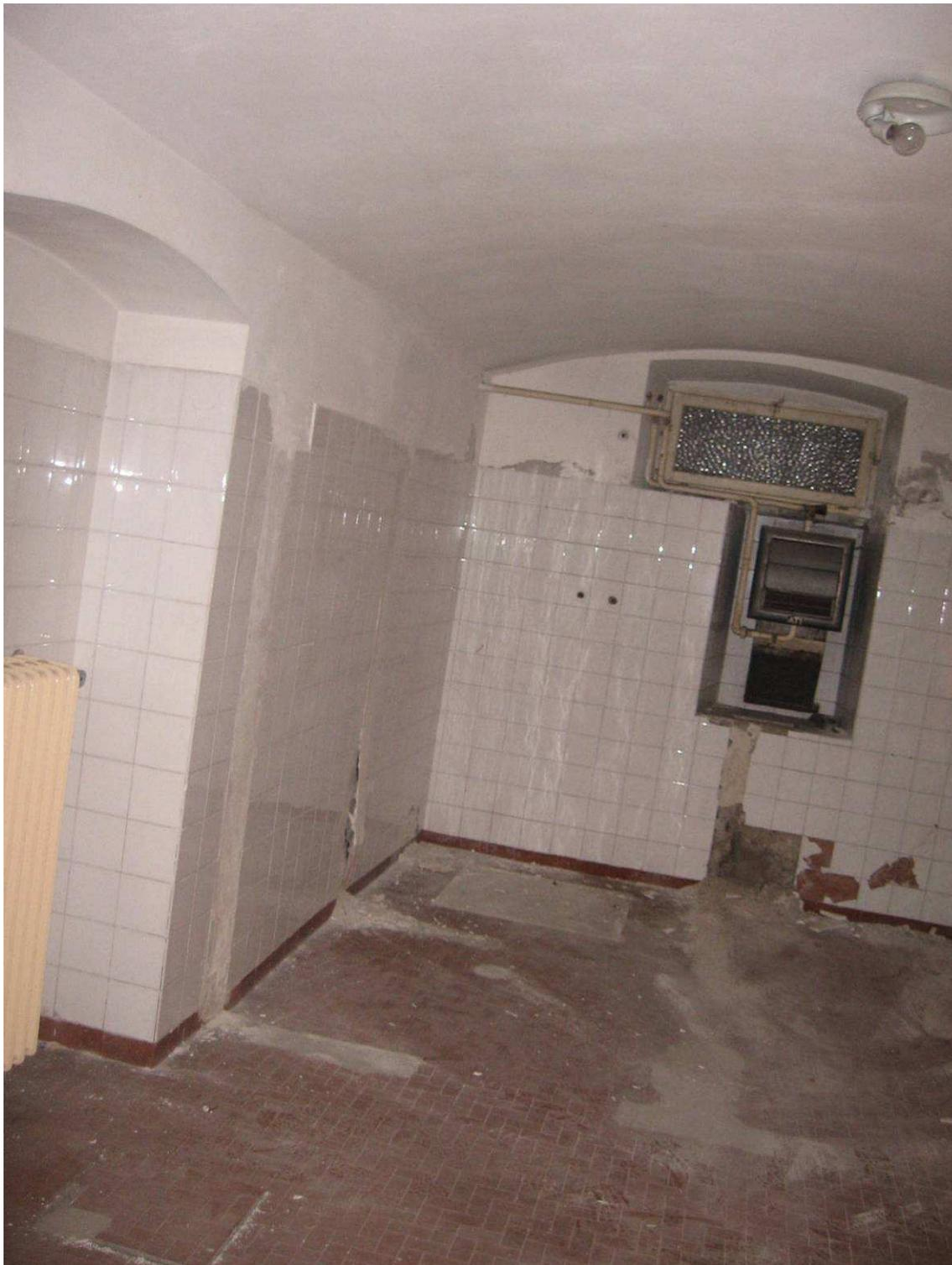
**Figura 2-20 RILIEVO R.A.11.A - Questo locale situato al piano interrato presenta una copertura realizzata con una volta in muratura.**
