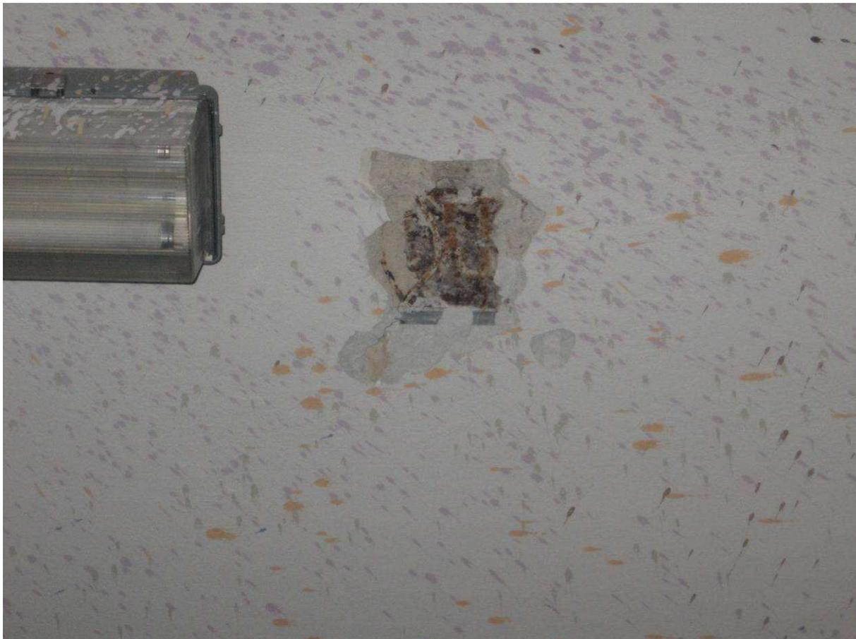
**Figura 2-10 Sondaggio a soffitto sul solaio di piano primo in corrispondenza delle putrelle.**
