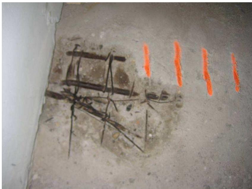
Figura 2-112 Sondaggio in corrispondenza dell'attacco al muro del solaio Matrai tipo 3.
