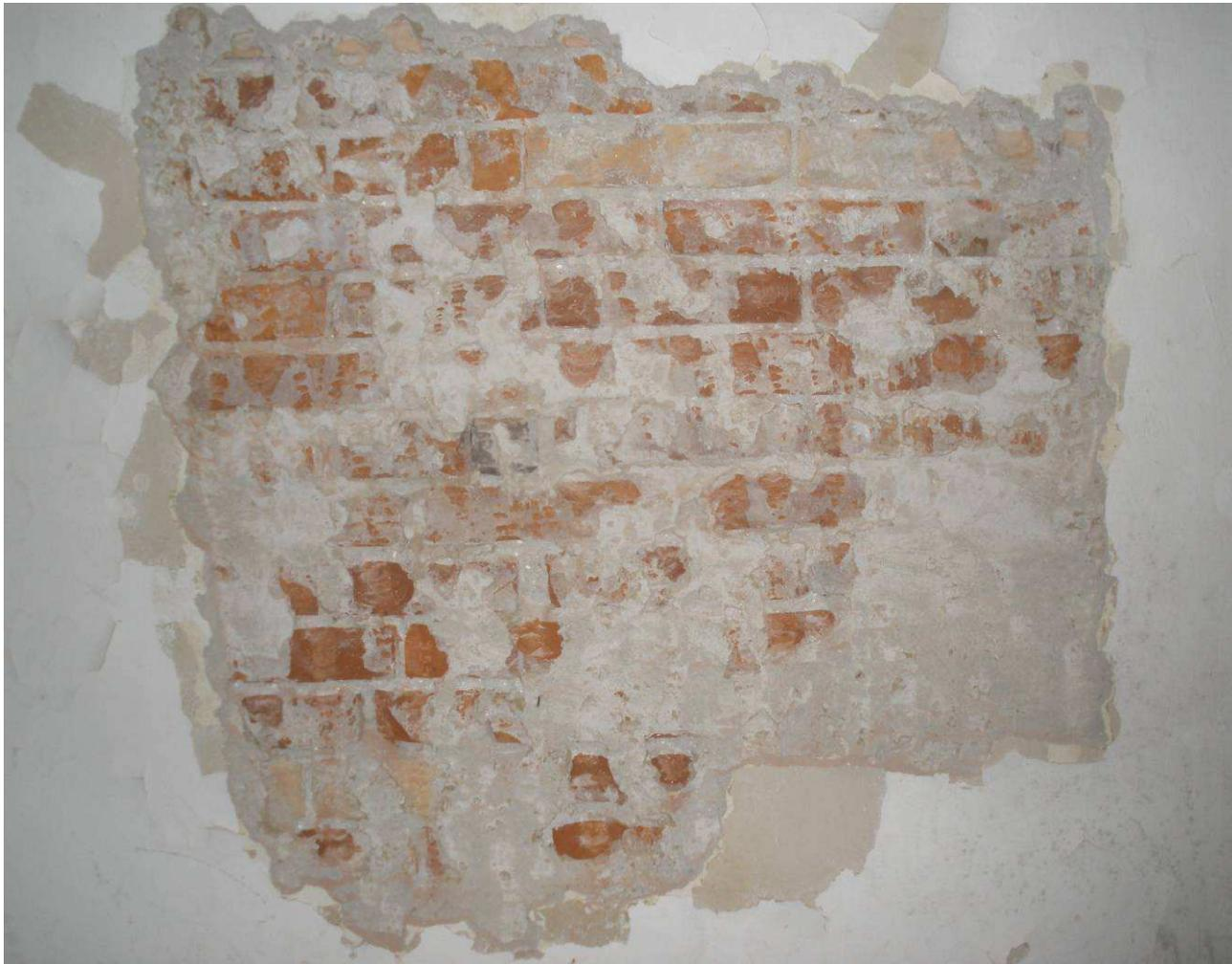
**Figura 2-36** Sondaggio a parete in cui si evidenzia 1 cm di intonaco e una parete di mattoni pieni.
