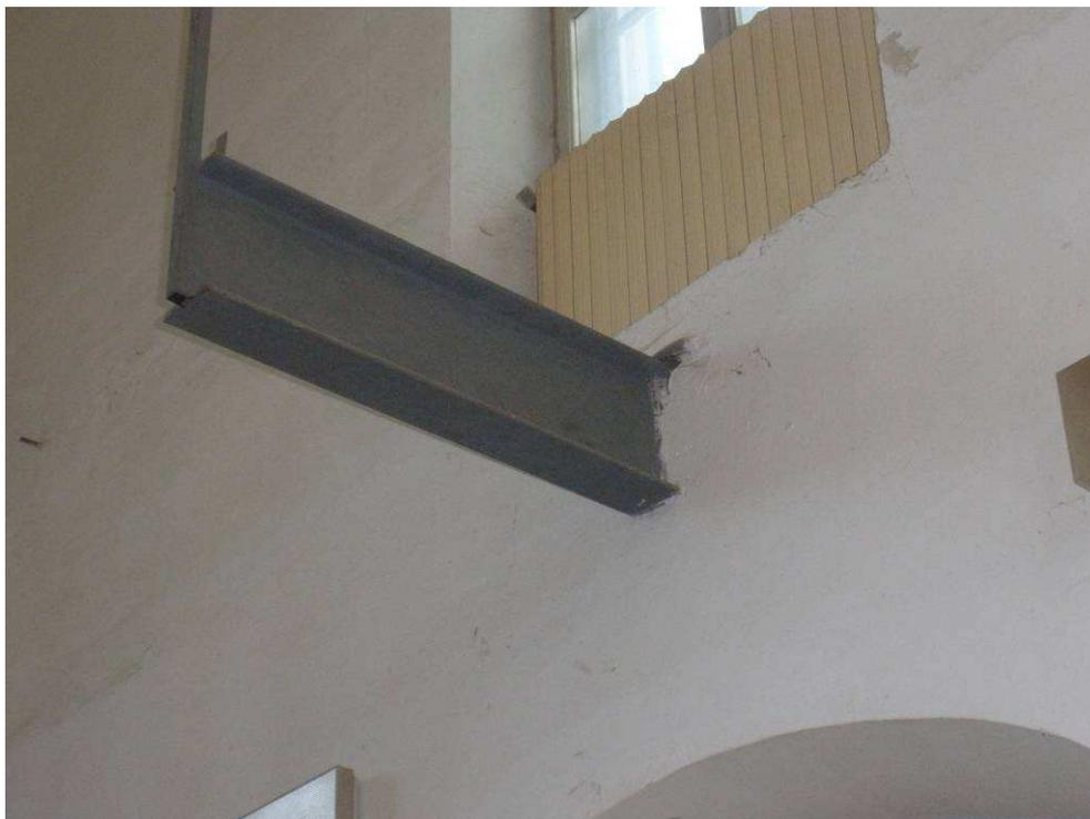
Figura 2-4 Putrelle in acciaio al 1° piano rimaste dopo la demolizione.
