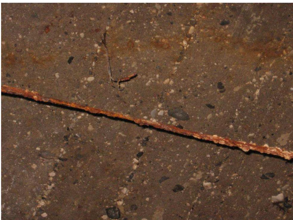
**Figura 2-34** Le armature venivano legate alle putrelle, come evidenziato da queste foto. Per sorreggere i controsoffitti erano stati inseriti uncini metallici a cui appendere i pannelli.
