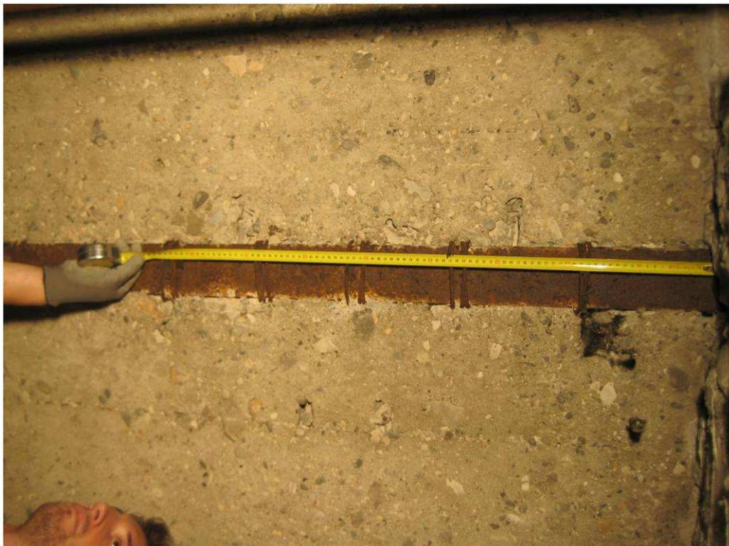
**Figura 2-116 Rilievo dell'intradosso del solaio Matrai tipo 1 del piano interrato in corrispondenza della putrella. Si è misurata la base della putrella e valutato l'interasse tra i fili del solaio.**
