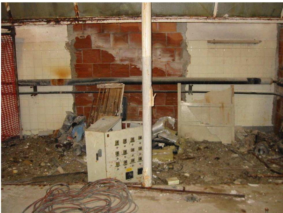
**Figura 6-35 Rilievo degli archi tamponanti nel locale cucina**
